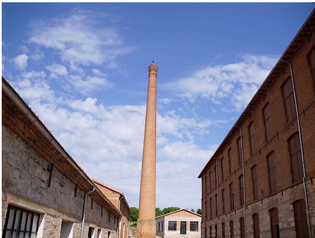
Εικόνα 4.7: Εργοστάσιο Τζίβρε με την περίφημη καμινάδα του 35 μέτρων
