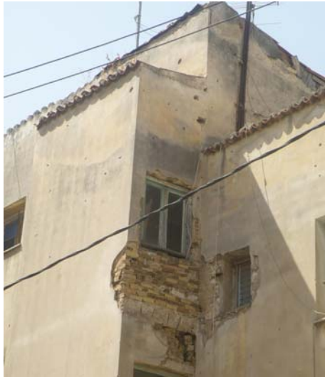
Σχήμα 4.3: Φθορές στο κέλυφος
