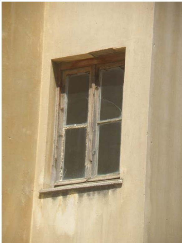
Σχήμα 4.5: Κουφώματα με μονό υαλοπίνακα
