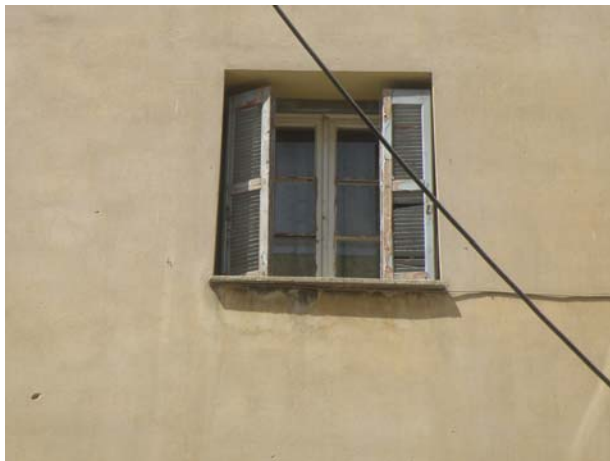
Σχήμα 4.18: Υπάρχοντα κουφώματα (με ξύλινα πατζούρια, ποσοστό πλαισίου 20% και μονό υαλοπίνακα)
