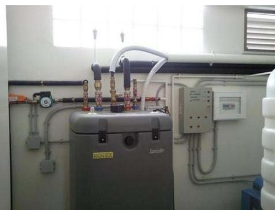
Σχήμα 5.18: Λέβητας φυσικού αερίου
