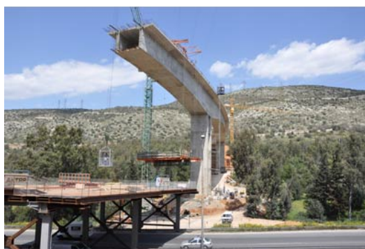
Εικόνα 20 κατά την κατασκευή της γέφυρας
