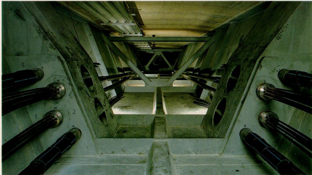
Εικόνα 22 Εφαρμογή ευθύγραμμης προέντασης σε γέφυρα
