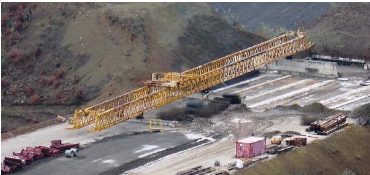
Εικόνα 1 Προκαταρκτικές εργασίες κατασκευής γέφυρας
