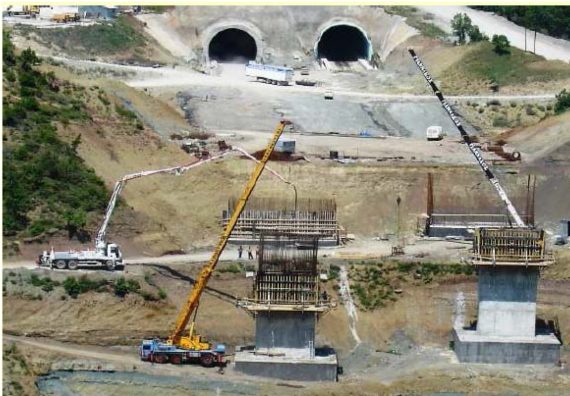
Εικόνα 11 Ανυψωτικό μηχάνημα και μηχάνημα σκυροδέτησης
