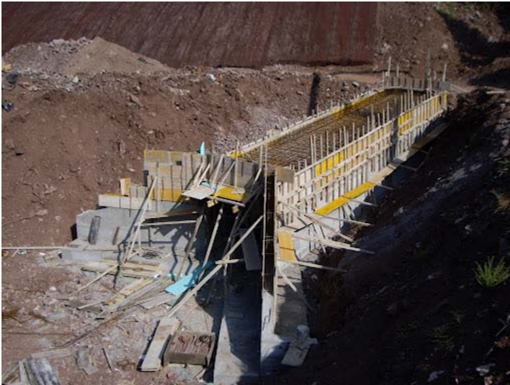
Εικόνα 3 Ξυλότυπος κατασκευής πτερυγότοιχου
