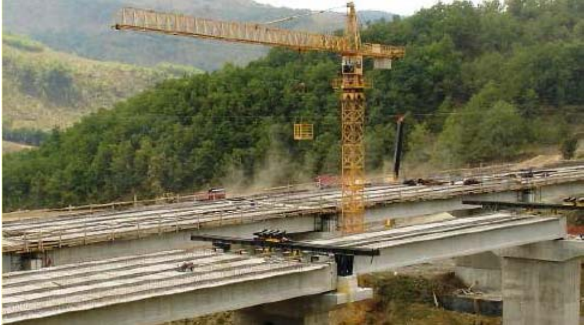
Εικόνα 10 Γερανός μεταβλητής ακτίνας κατά την κατασκευή ανωδομής
