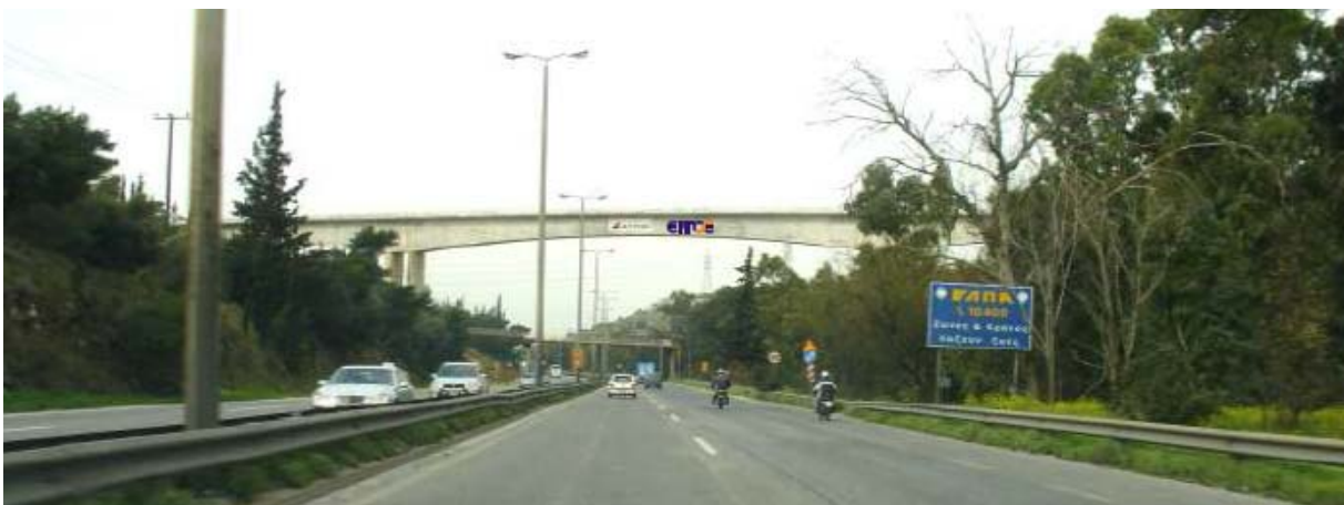
Εικόνα 18 Τμήμα της γέφυρας πάνω από την Εθνική οδό
