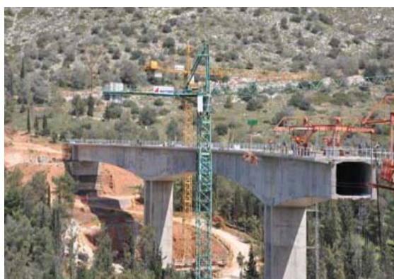
Εικόνα 23 Κατά την κατασκευή του τρίτου μεσόβαθρου
