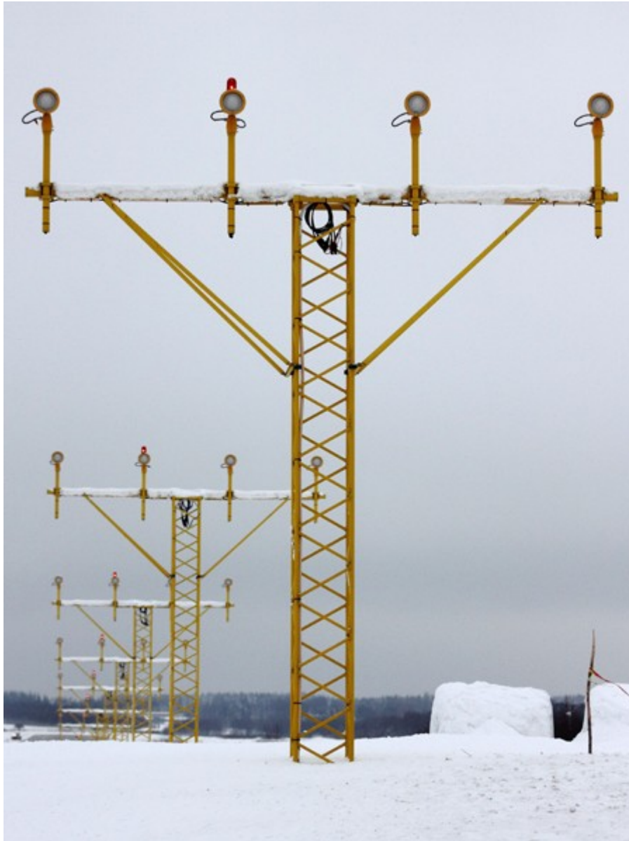
Σχήμα 2.1.2 Οριζόντια μπάρα φώτων
