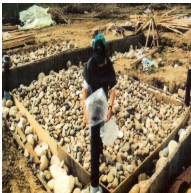
α. Το κύκλωμα θερμού - ψυχρού αέρα β. Κατασκευή Rock Bed μεταξύ θερμοκηπίου και Rock Bed
