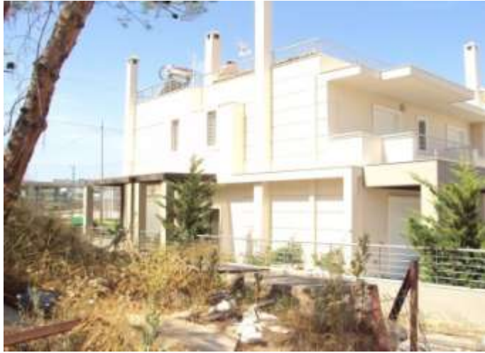
Εικόνα 29. Ώρα 11:00 Η ανατολική πλευρά του κτίσματος.
