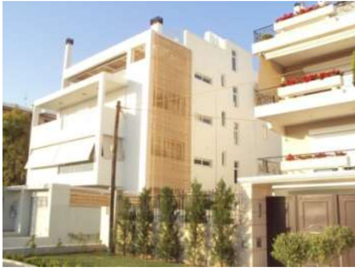
Εικόνα 42. Σύγχρονες Πολυκατοικίες στη Γλυφάδα με τοποθετημένα εξωτερικά σκίαστρα στη ανατολική τους όψη.
