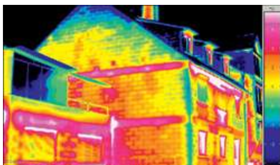
Εικόνα 11. Θερμικές απώλειες χωρίς εξωτερική θερμομόνωση
