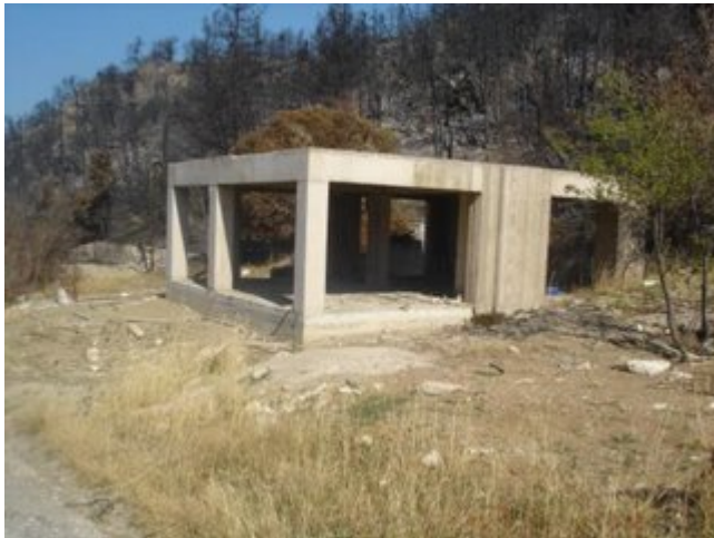
Φωτ. [57] Αυθαίρετο κτίσμα μια ανάσα από τα καμένα
