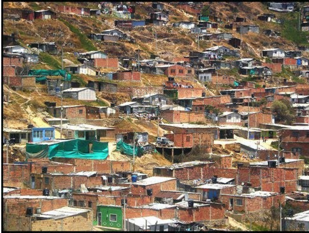
Φωτ[58] Αποτέλεσμα αυθαίρετης δόμησης
