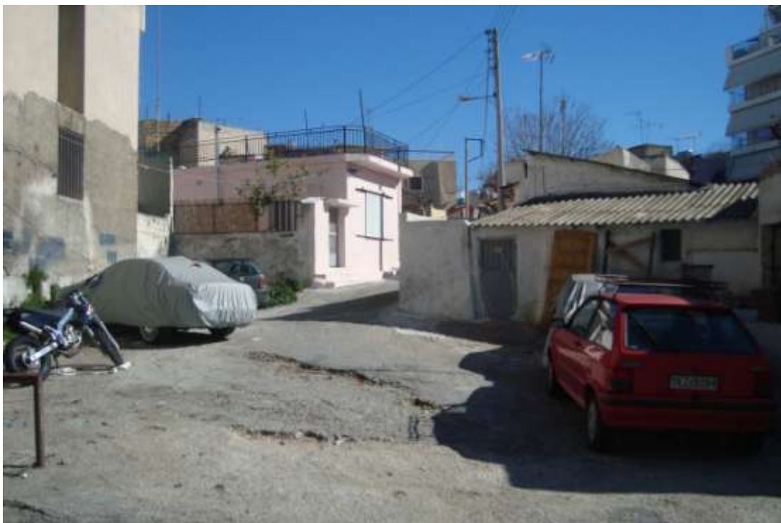
Εικόνα 31. Οργανωμένους χώρους στάθμευσης δεν εντοπίσαμε ανταυτού εντοπίσαμε αναξιοποίητα οικόπεδα τα οποία οι κάτοικοι τα έχουν μετατρέψει αυθαίρετα σε χώρους στάθμευσης.
