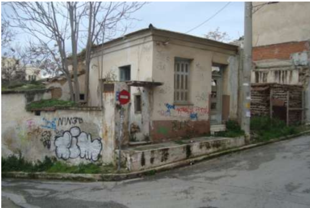
Εικόνα 59. Το κτίσμα της εικόνας φέρει νεοκλασικά στοιχεία στην οροφή
