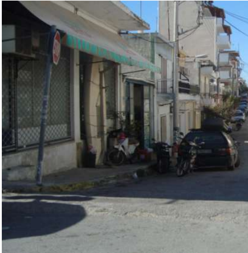
Εικόνα 53. Χρήση γης, σε τυπική συνοικία των Μανιάτικων, συνηθίζεται (επιτρεπόμενο βάση νομοθεσίας) το ισόγειο να χρησιμοποιείται ως κατάστημα και οι όροφοι ως οικίες.
