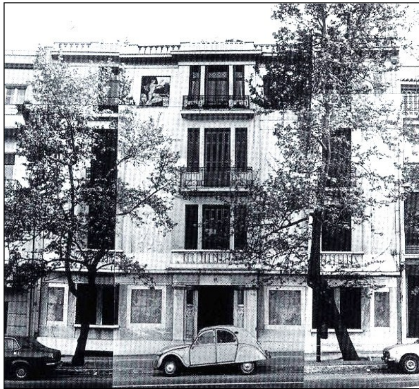
14. Κτίριο στην οδό Διον. Αρεοπαγίτου (1924- 25). Αρχιτέκτων: Β. Κουρεμένος.
