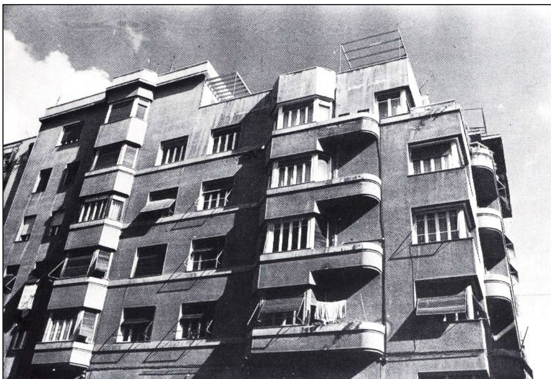
41. Κ. Σγούτας, Πολυκατοικία στη Λυκαβηττού- Σόλωνος (1934).
