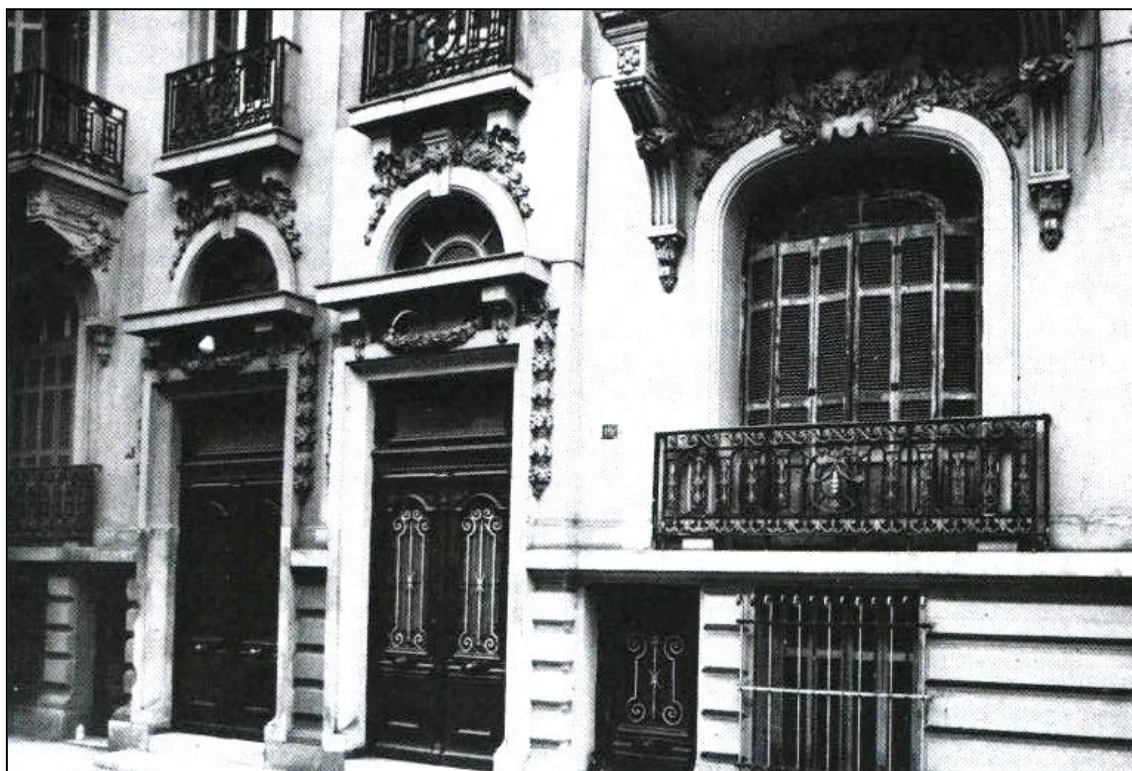
27. Τμήμα κτιρίου στην Ιουλιανού 15.
