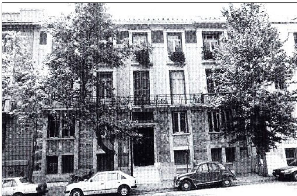
17. Κτίριο στην οδό Λιον. Αρεοπαγίτου 37 (1929). Αρχιτέκτων: Β. Κουρεμένος.
