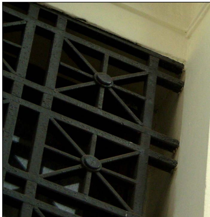
69 β. Λεπτομέρεια κιγκλιδώματος.
