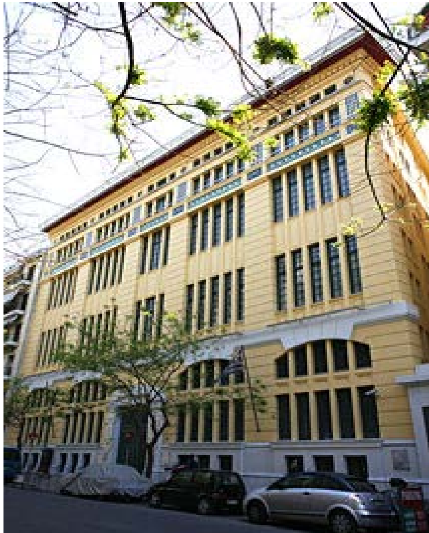
55. Κτίριο Ιστορικού Αρχείου Εθνικής Τράπεζας στην οδό Γ' Σεπτεμβρίου 146.
