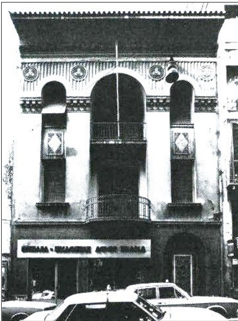
26. Κτίριο στην Τρικούπη 11 με στιχρεία Art Nouveau.
