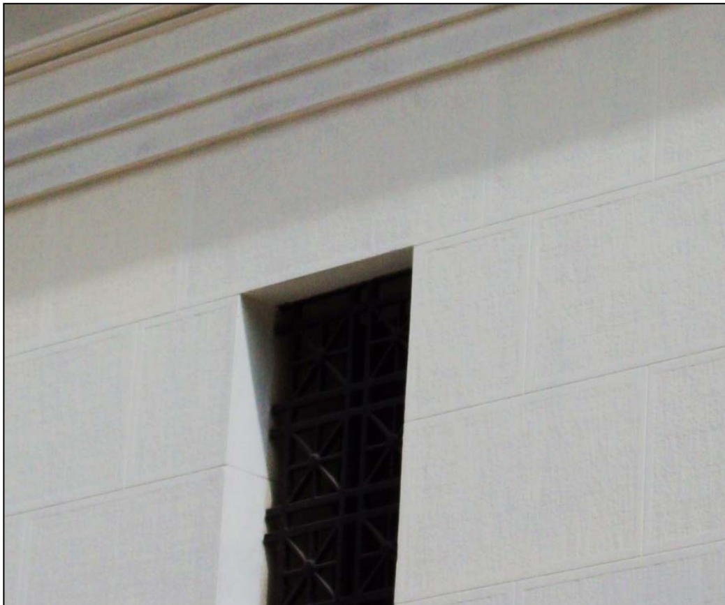
72. Ανάγλυφη επιφάνεια τοίχου- τσιμεντόλιθοι, λεπτομέρεια.
