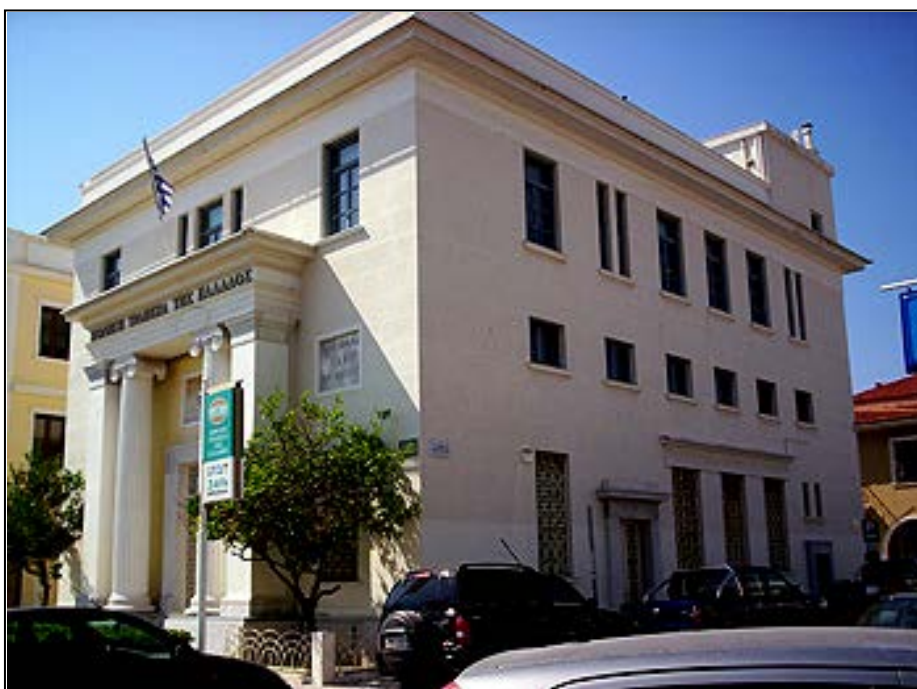
59. Υποκατάστημα Εθνικής Τράπεζας της Ελλάδος στη Ζάκυνθο. Επισκενή- Αναπαλαίωση.
