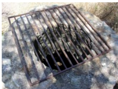
Εικόνα 24. Η δεξαμενή νερού με βάθος περίπου 8 μέτρα (προέλευση φωτογραφικό υλικό Μιχάλη Τζιώτη).
