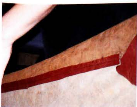
Εικ. 23 & 24: Άνοιγμα και κόλλημα ραφής
