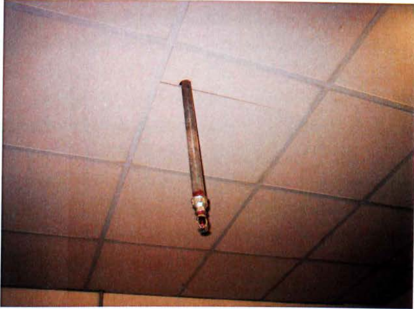
Καταιονητήρας (sprinkler)
