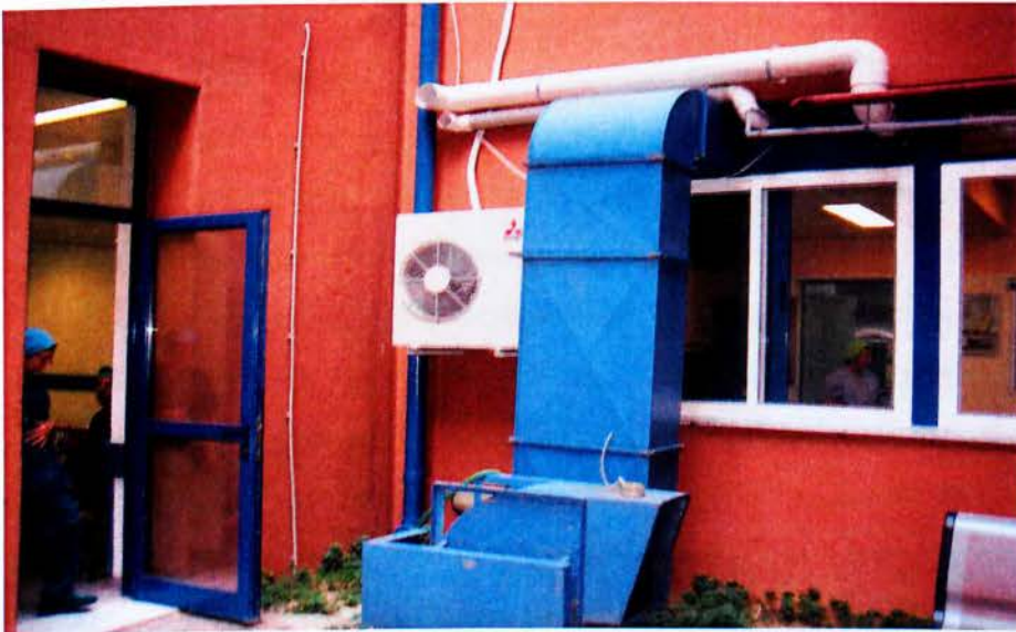
Εξωτερικό κανάλι κλιματισμού και εξαερισμός χώρου
