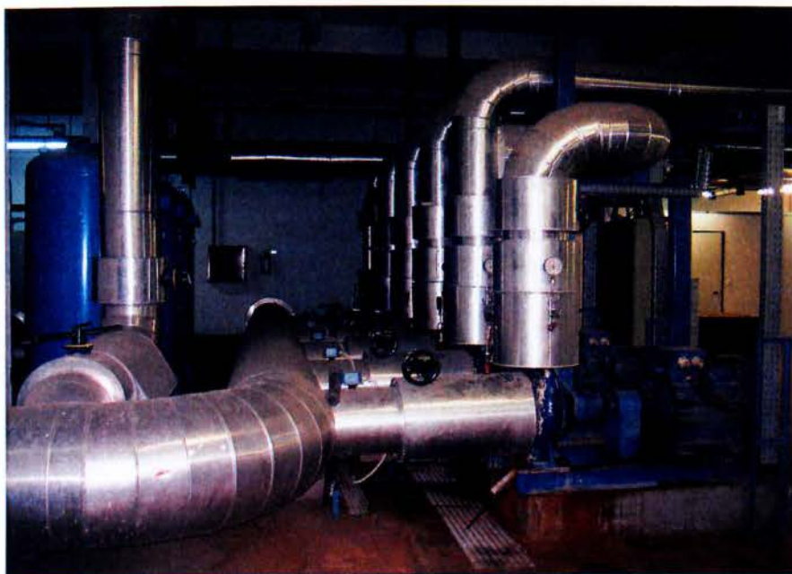
Εγκατάσταση κλιματισμού στον μηχανοστάσιο
