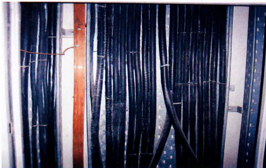
Οδευση τηλεφωνικών καλωδίων εντός εύκαμπτου πλαστικού σωλήνα
