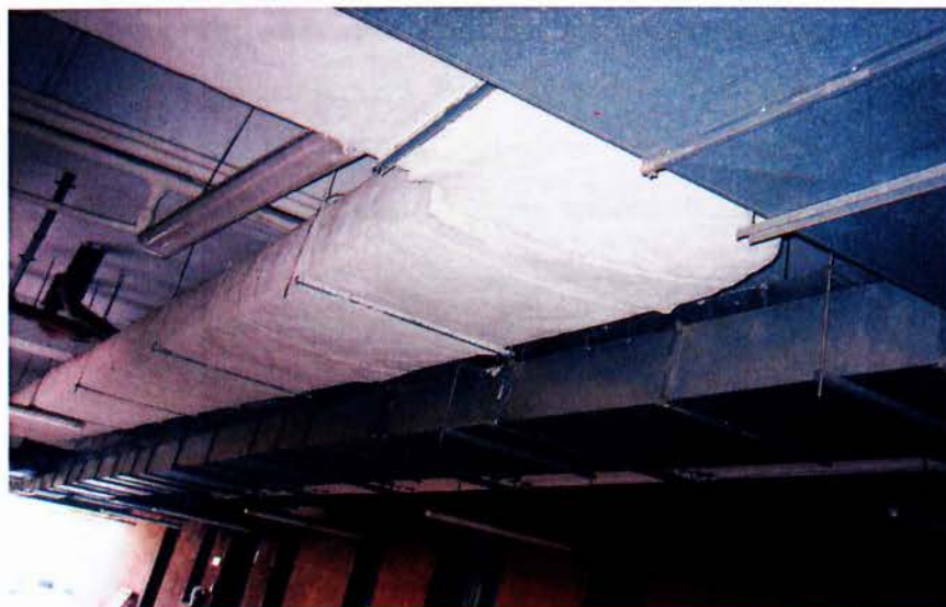
Οριζόντια όδευση καναλιού κλιματισμού με μόνωση περιφερειακά
