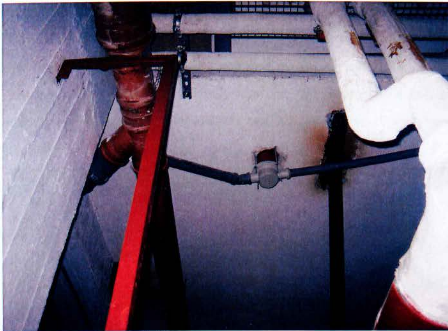
Οριζόντια όδευση μέσα στην ψευδοροφή του από κάτω ορόφου
