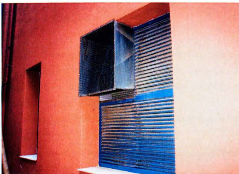
Αερισμός μηχανοστασίου
