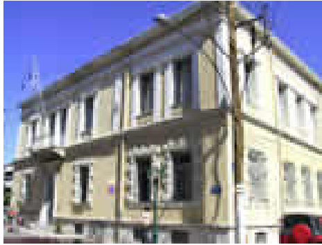
Εικ. 1.10.: Το κτίριο της Νομαρχίας Αρκαδίας
