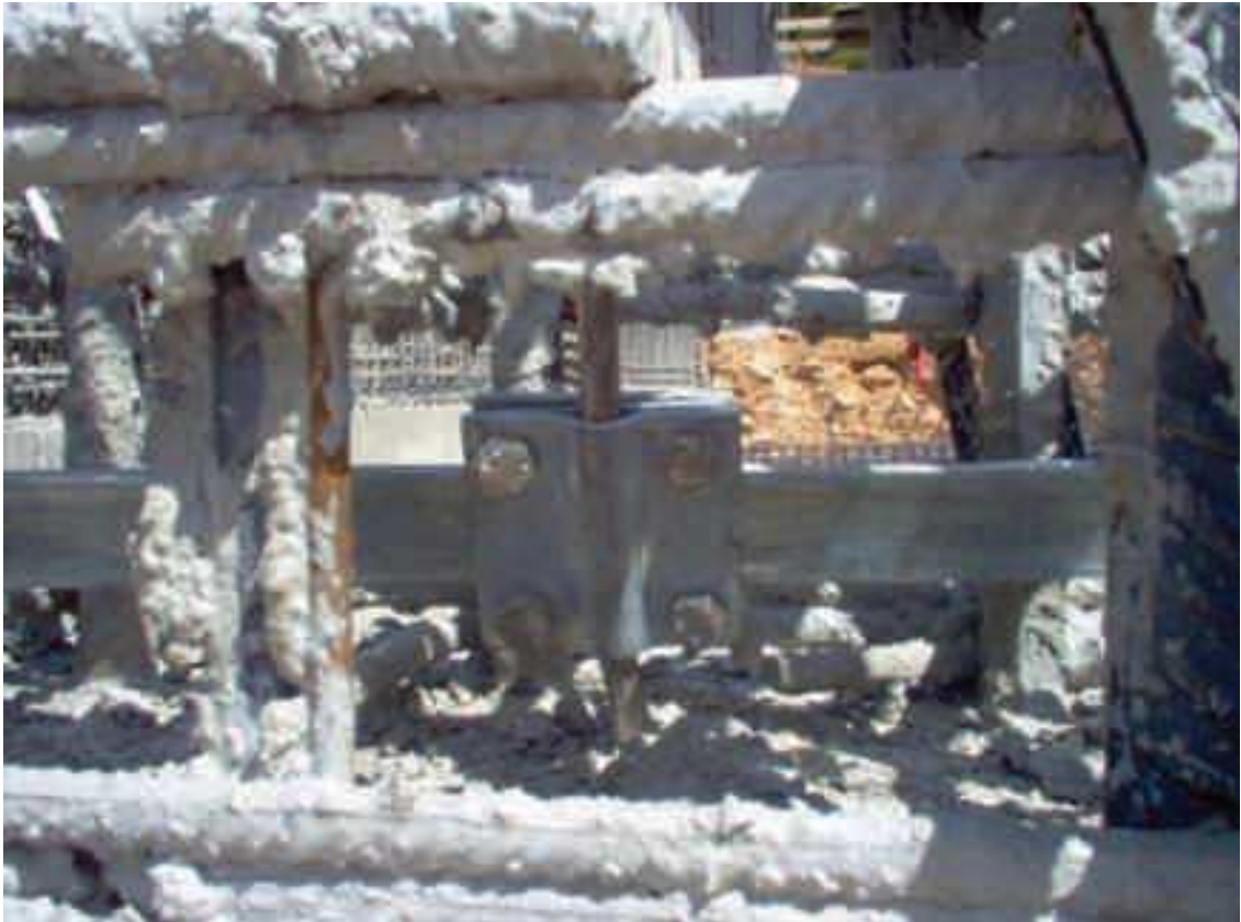
Σχήμα 3.2 Σύνδεση ταινίας γείωσης με τον σπλισμό του κτιρίου με ειδικό τεμάχιο St/tZn
