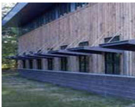
Σχήμα 6.11 Εξωτερικά ράφια φωτισμού
