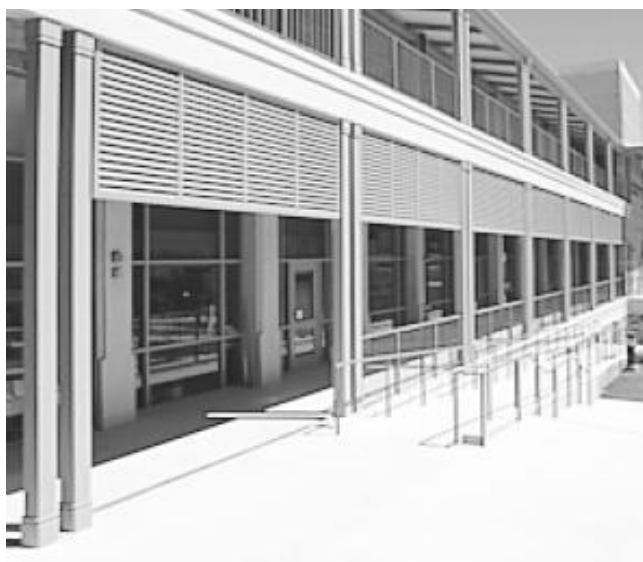
Σχήμα 5.3 Οριζόντιες εξωτερικές περσίδες, κατάλληλες για νότιο προσανατολισμό. Λειτουργούν αποδοτικά, εκτός από τις γωνίες. Διπλή σειρά περσίδων έχει χρησιμοποιηθεί
