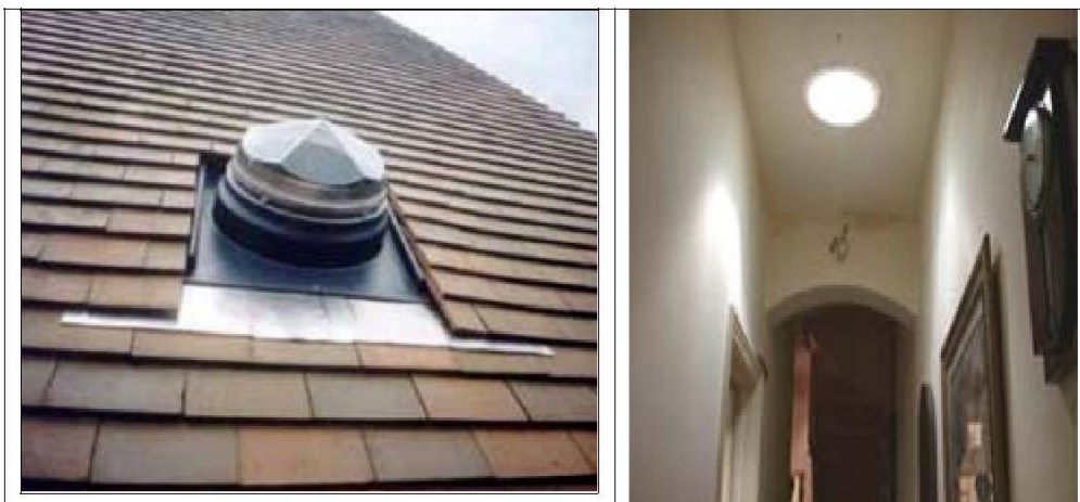
Σχήμα 6.8 Χρήση φωτοσωλήνων για φυσικό φωτισμό .
