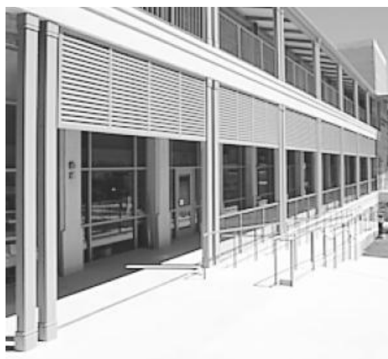
Σχήμα 5.4 : Διάταξη από κάθετες, σταθερές, εξωτερικές περσίδες, κατάλληλες για ανατολικό και δυτικό προσανατολισμό
