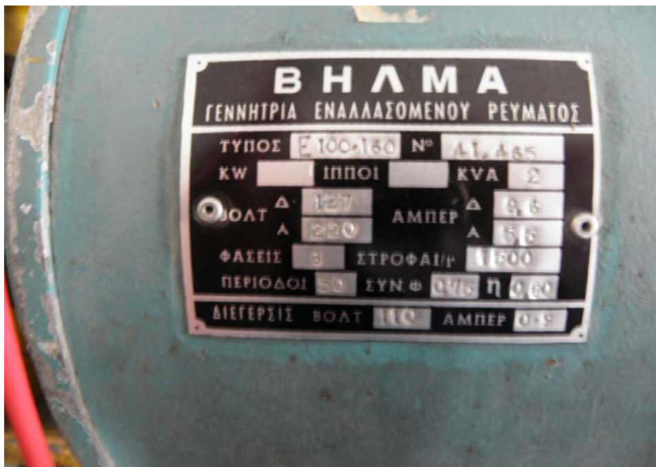
Σχήμα 2.2.1. Χαρακτηριστικά γεννήτριας εναλλασσομένου ρεύματος
