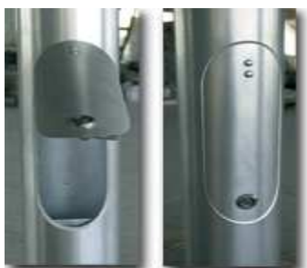
Λεπτομέρεια θύρας πρόσβασης ιστού φωτισμού με εσωτερικό μεντεσέ και κλειδαριά ασφαλείας
