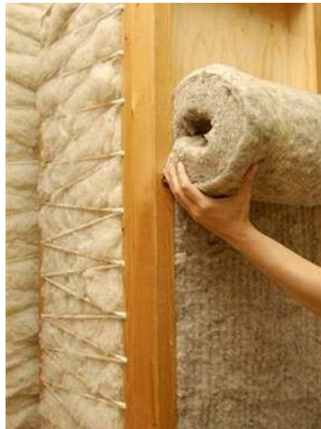
Εικόνα 2.4.2.5 Τοποθέτηση θερμομόνωσης
