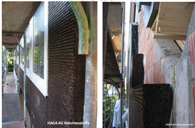
2.4.3.9 Εξωτερική θερμομόνωση φελλού
