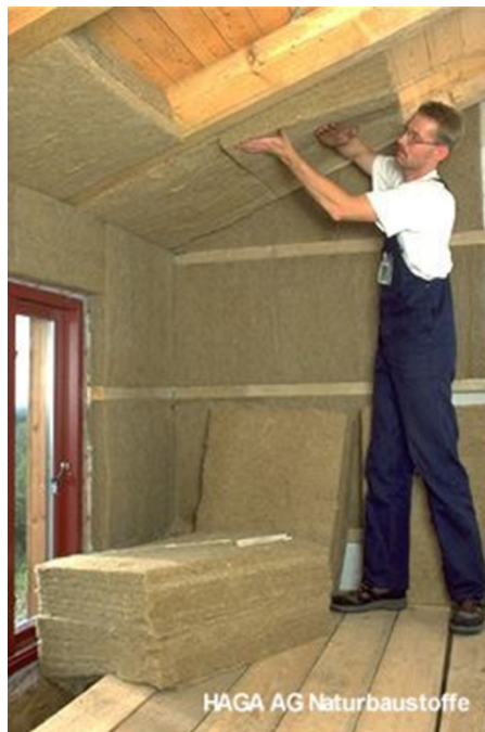
2.4.6.6 Τοποθέτηση θερμομόνωσης λιναριού
