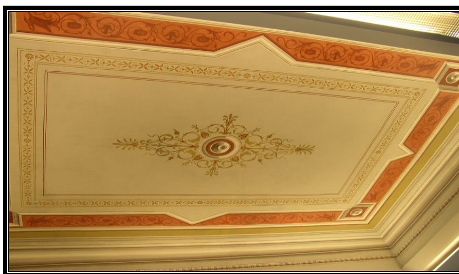
Εικόνα 30. Οροφografia του κτιρίου
