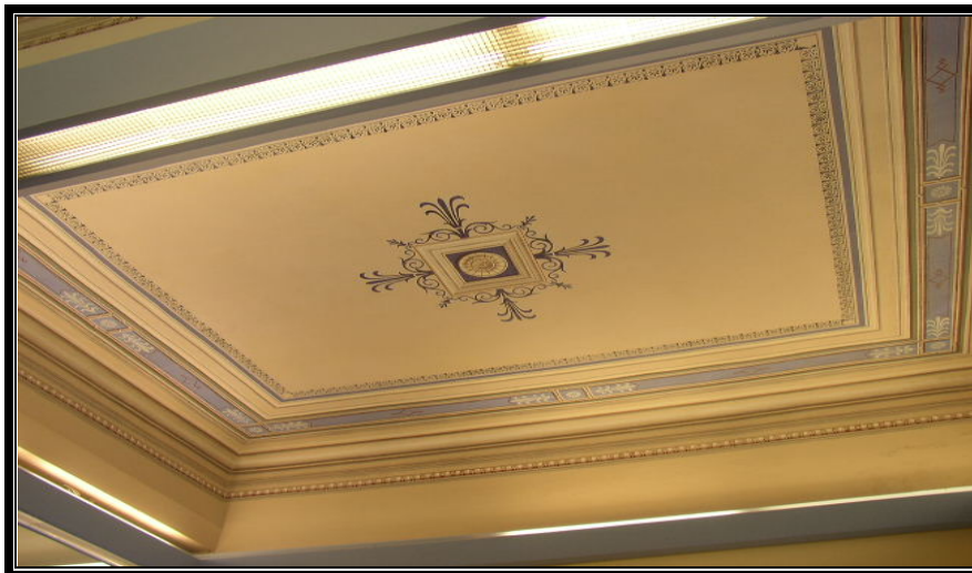
Εικόνα 29. Οροφografia του κτιρίου
