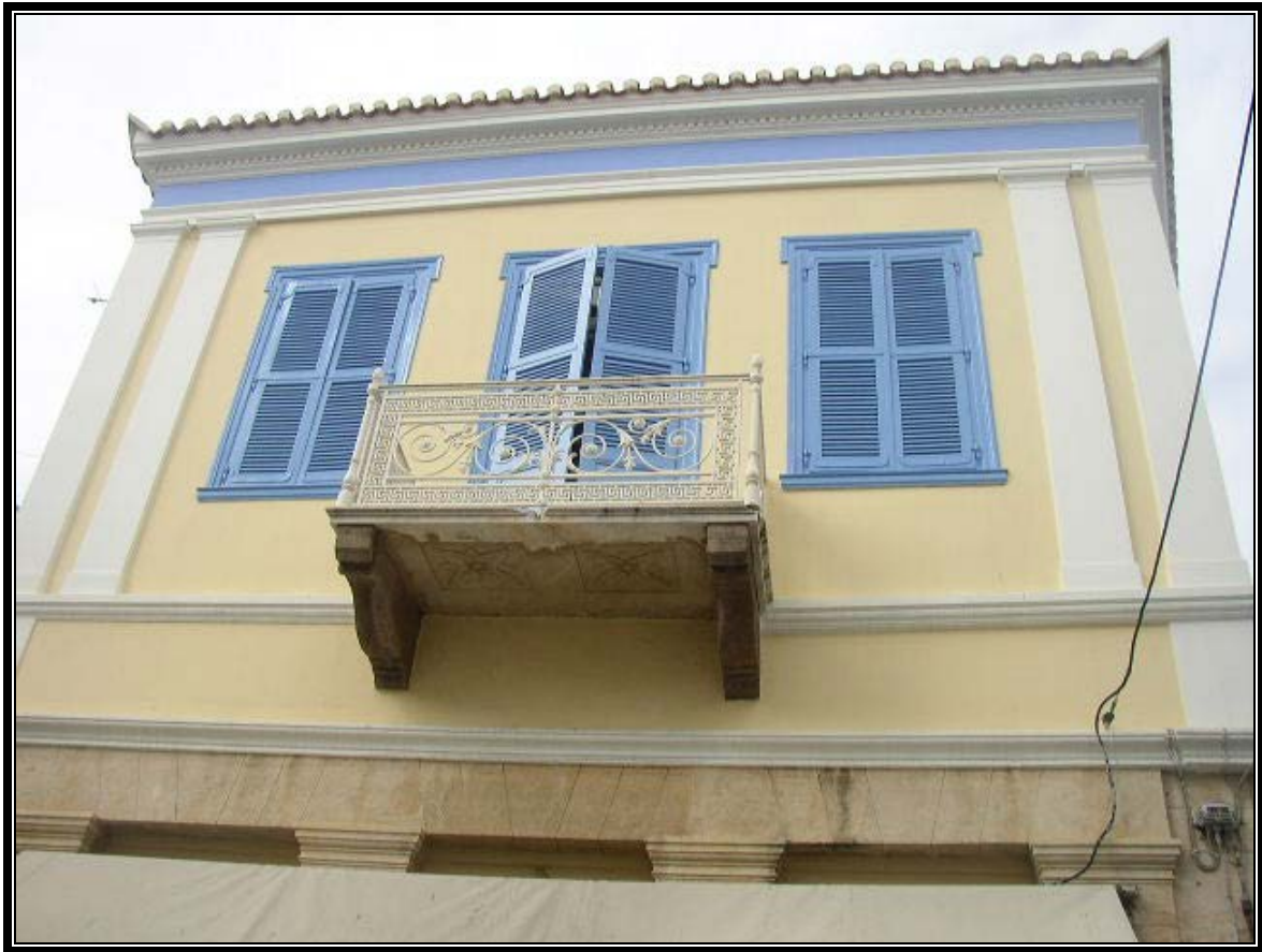
Νεοκλασικό κτίριο επί της οδού Σπύρου Ρόδη
