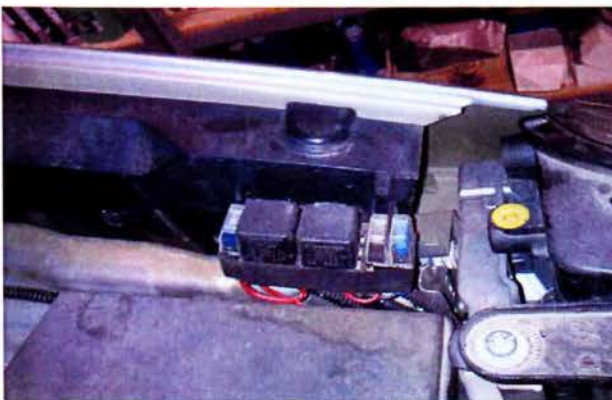
ΕΙΚΟΝΑ 5.11 Ασφάλειες ηλεκτρονικού κυκλώματος.
