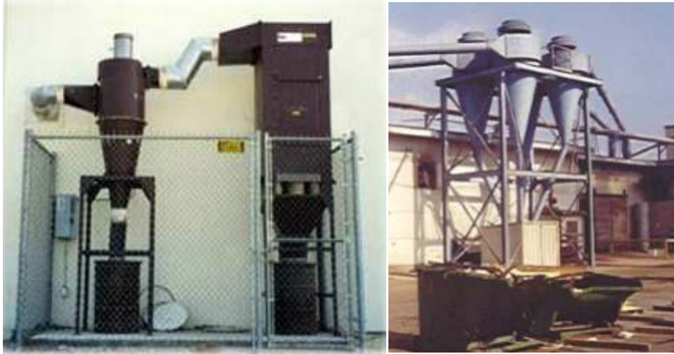
Εικόνα 21 Κυκλώνες για απομάκρυνση της σκόνης
