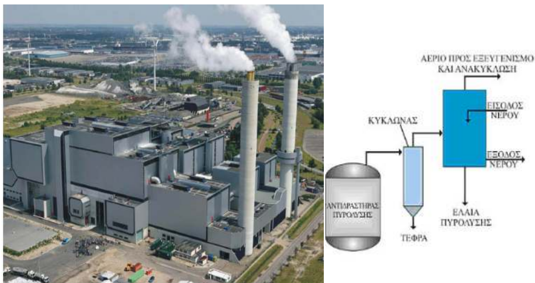
Εικόνα 16 Μονάδες αποτέφρωσης στερεών αποβλήτων στο Άμστερνταμ και διεργασία πυρόλυσης
