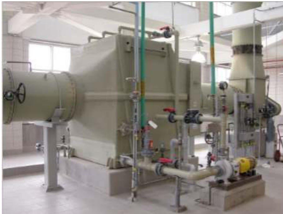
Εικόνα 36 Πλυντρίδα με πληρωτικά υλικά σε διασταυρούμενη ροή
