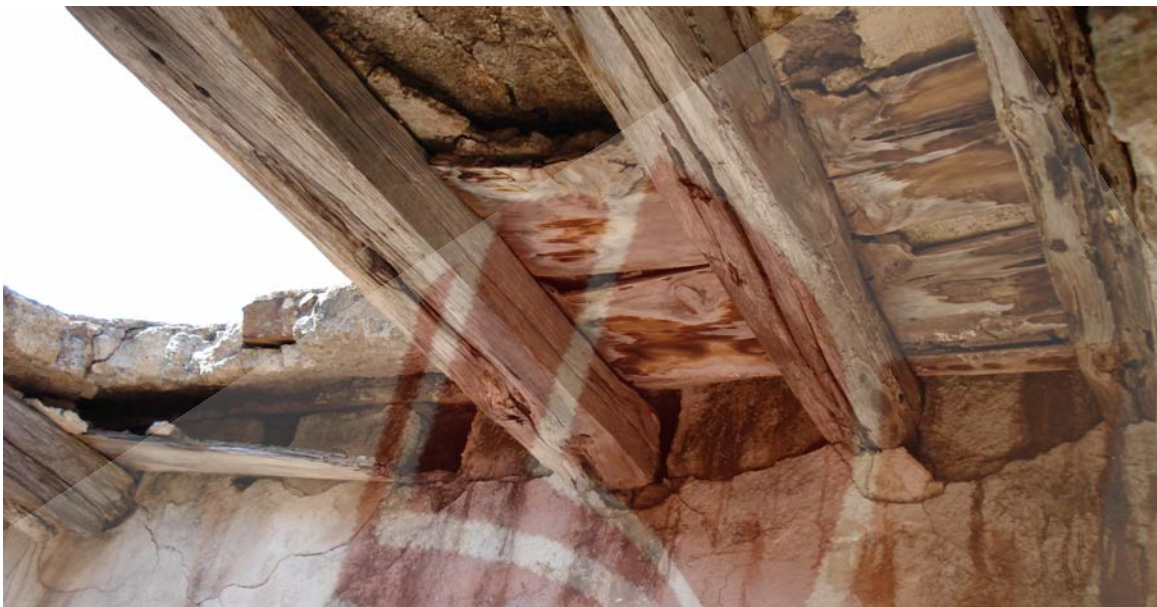
Εικ. 10.7 Το βέλος κάμψης στην οροφή του δώματος.
