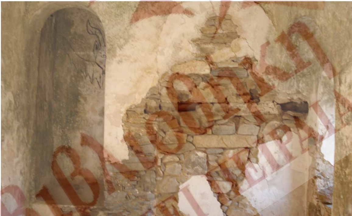
Εικ. 10.0 Οι σχιστόπλακες ως δομικό υλικό για την κατασκευή της τοιχοποιΐας.
