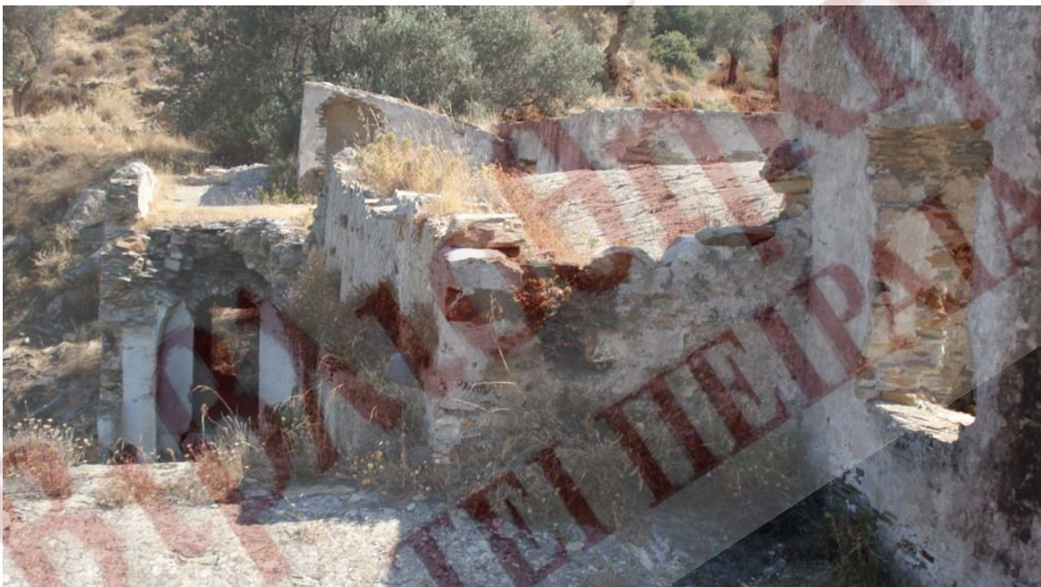
Εικ. 5.2 Η όψη του κλιμακοστασίου που έχει καταρρεύσει από την πλευρά του δώματος.
