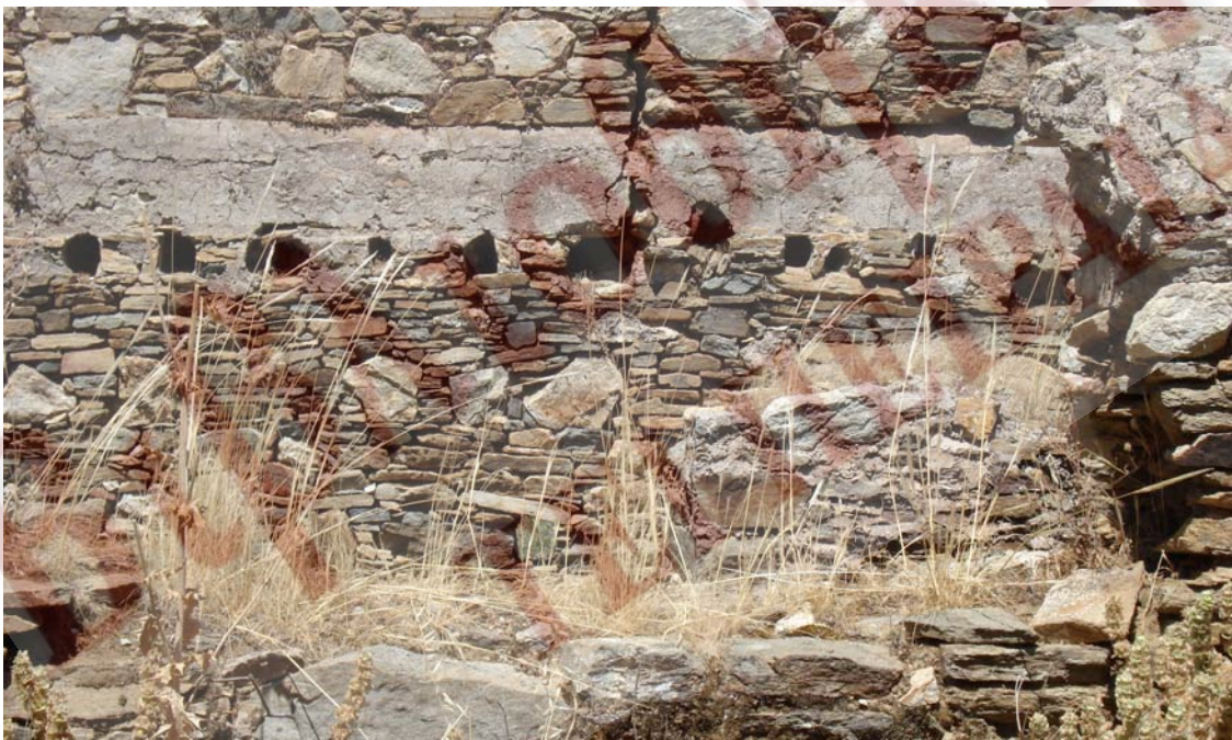
Εικ. 4.7 Οι εσοχές από τα δοκάρια του πατώματος.
