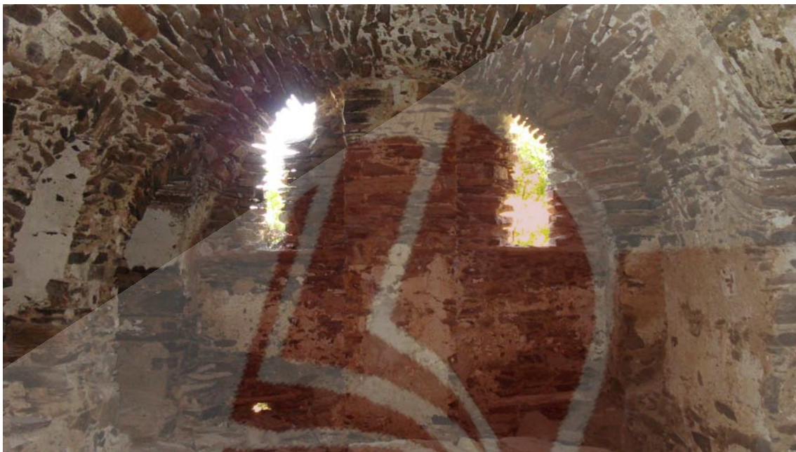
Εικ. 6.8 Τα παράθυρα του ελαιοτριβείου που μετατράπηκαν σε πολεμίστρες.
