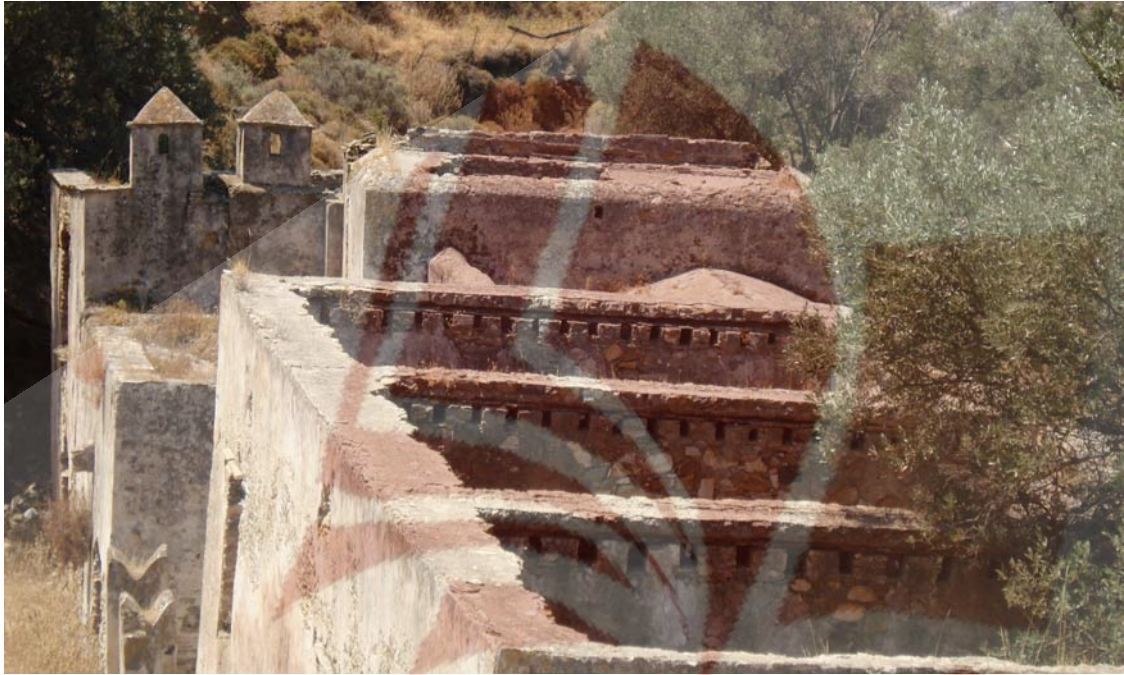
Εικ. 4.6 Οι εσοχές από τα δοκάρια της οροφής.
