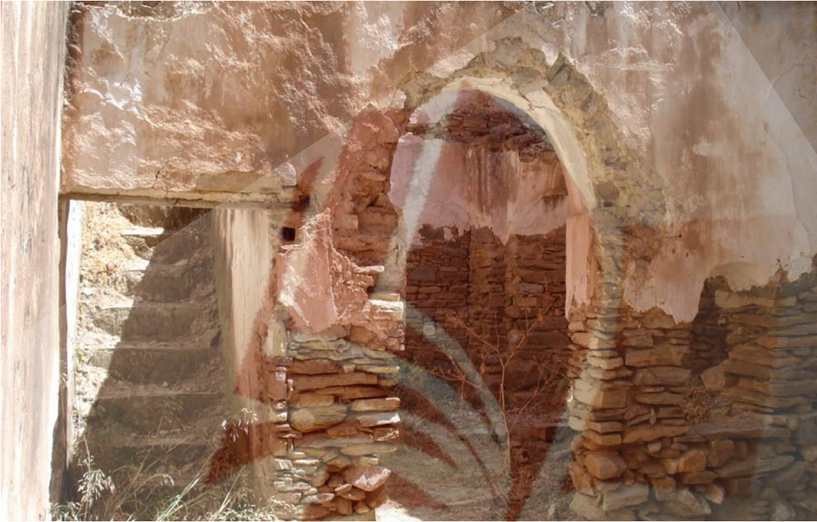
Εικ. 4.1 Ο χώρος που οδηγεί στον όροφο.
