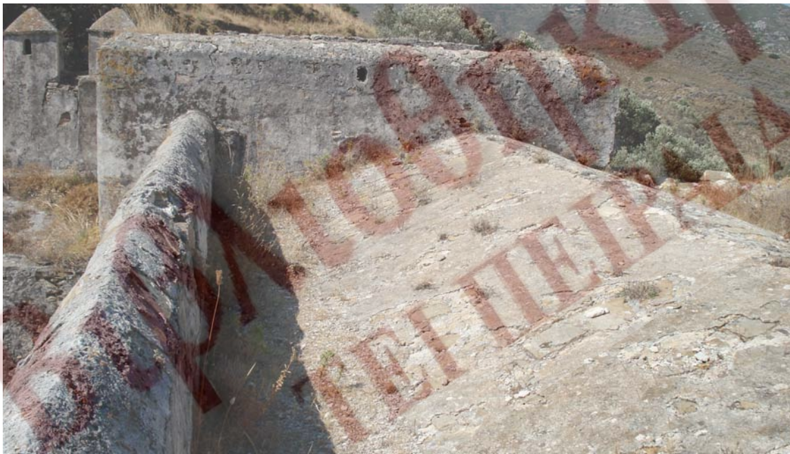
Εικ. 2.8 Το εξωρράχιο του θόλου.
