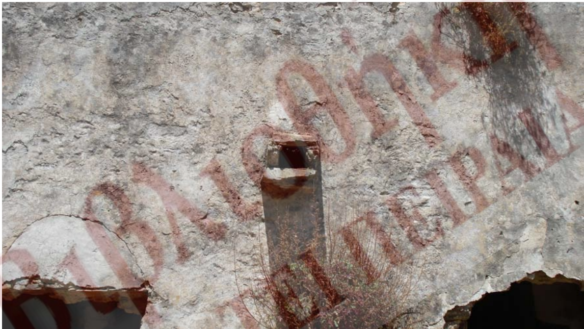
Εικ. 11.2 Όψη ζεματίστρας.
