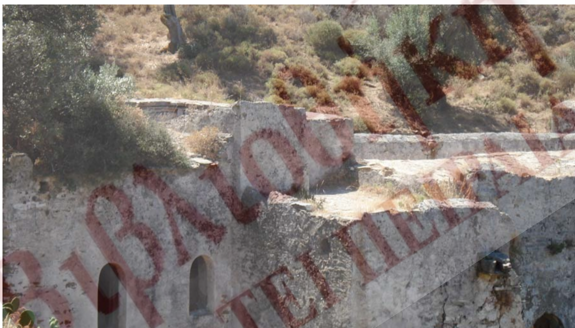
Εικ.11.4 Στην κύρια όψη διακρίνουμε ζεματίστρες ορθογωνικής και κοκλικής διατομής.
