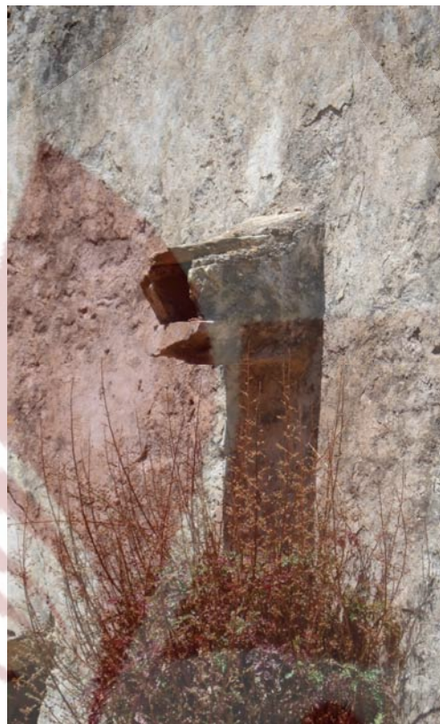
Εικ. 11.6 Πλάγια όψη ζεματίστρας.
