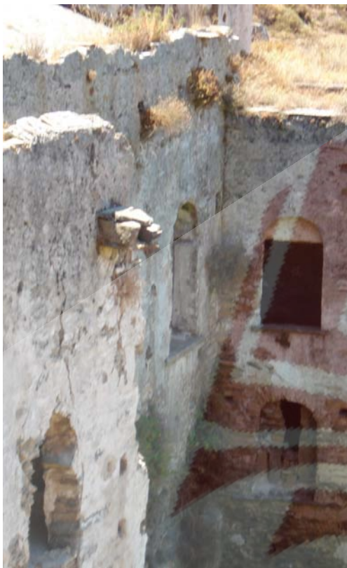
Εικ.11.5 Στοιχεία αμυντικού χαρακτήρα, η πολεμίστρα και η ζεματίστρα.
