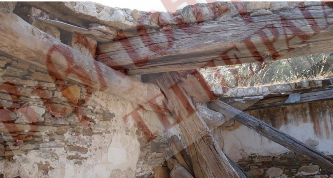
Εικ. 10.4 Η στήριξη των ξύλινων δοκαριών.
