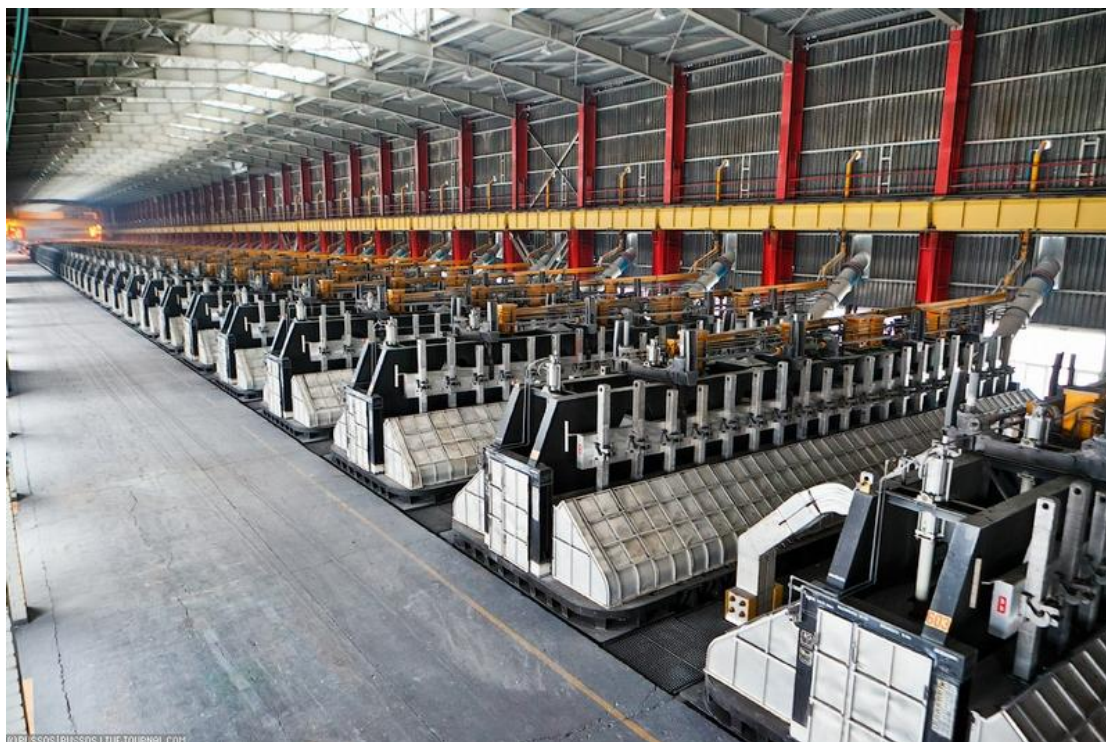
Εικόνα 5.5:Λεκάνες ηλεκτρόλυσης αλουμινίου
