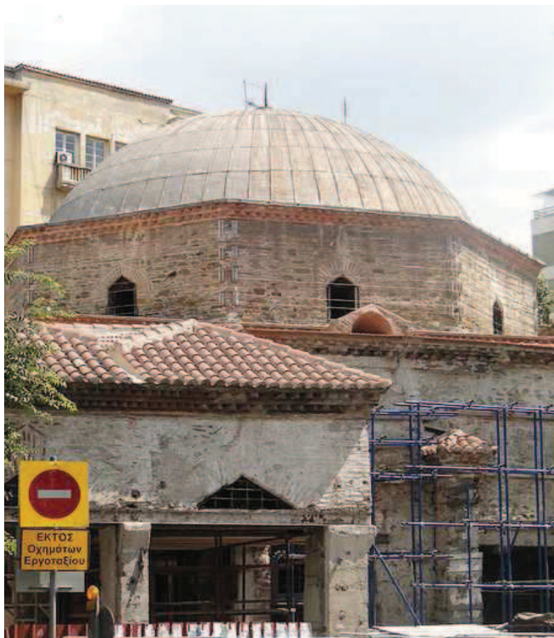
Εικ.2.38 Αναστηλωτικές εργασίες στο Χαμζά-Μπέη τζαμί
