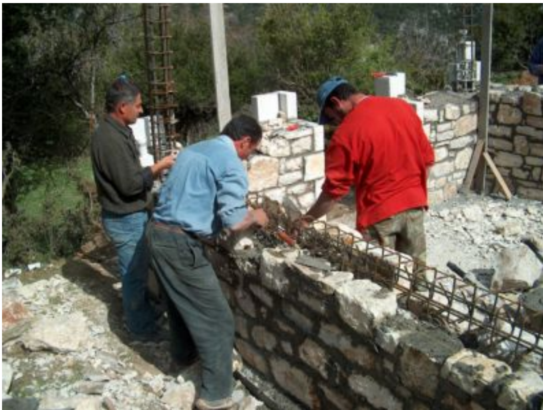
4. Κάθε 1,00μ-1,50μ κατασκευάζονται σενάζ.
