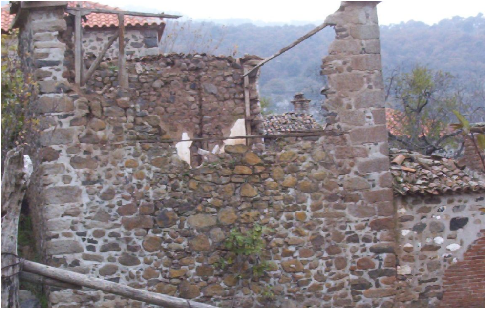
Σχ 11. Φαίνονται καθαρά τα ξύλα που εξυπηρετούν την αντισεισμική συμπεριφορά του κτιρίου. Κτίσμα σε ορεινό χωριό της Λέσβου.
