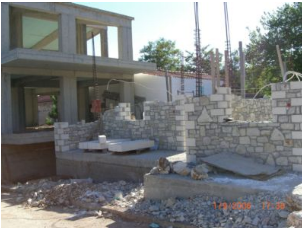
6. Περιμετρικό χτίσιμο τοίχων. Φαίνεται ο οπλισμός των κατακόρυφων σενάζ.
