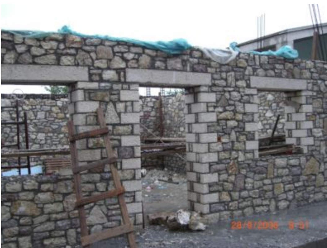
8. Ολοκληρωμένοι τοίχοι ισογείου. Φαίνονται ακρογωνιαίοι λίθοι και τα πέτρινα πρέκια.
