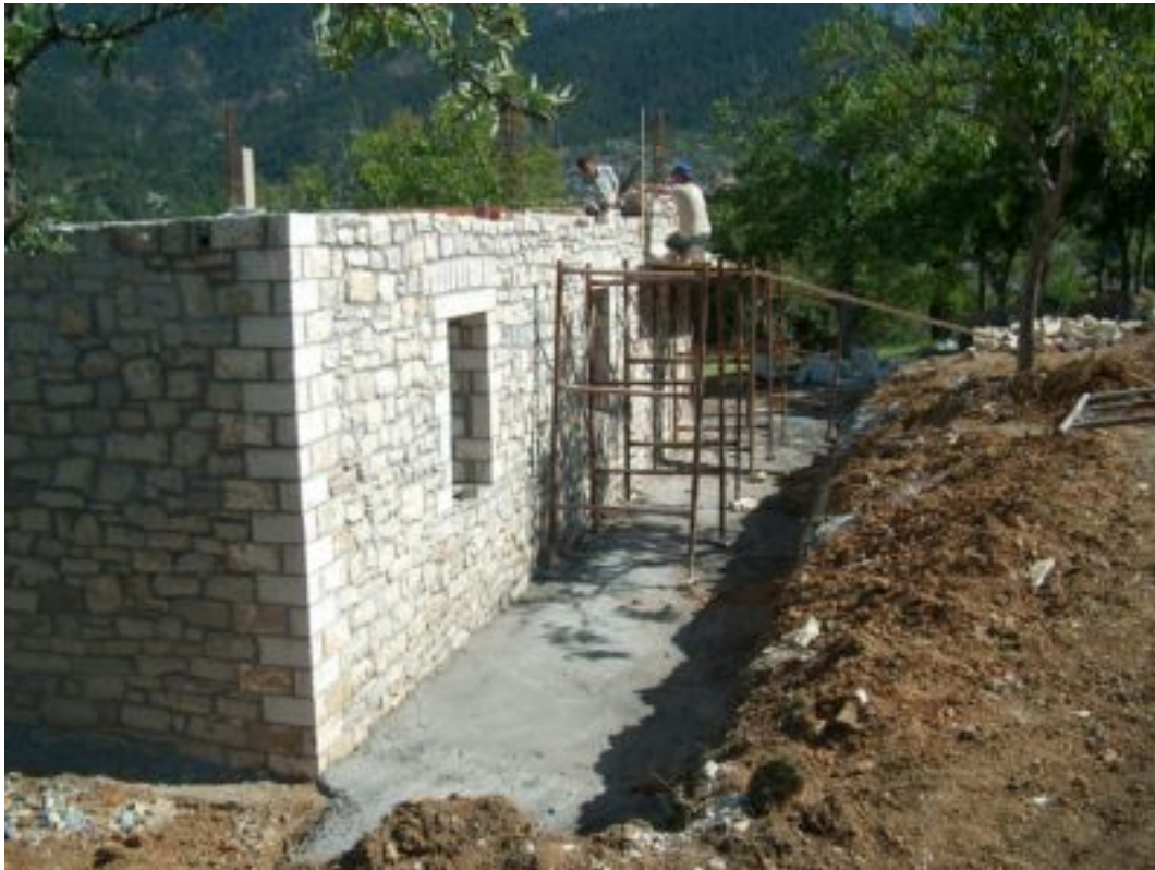
8. Τελειωμένοι εξωτερικοί τοίχοι.
