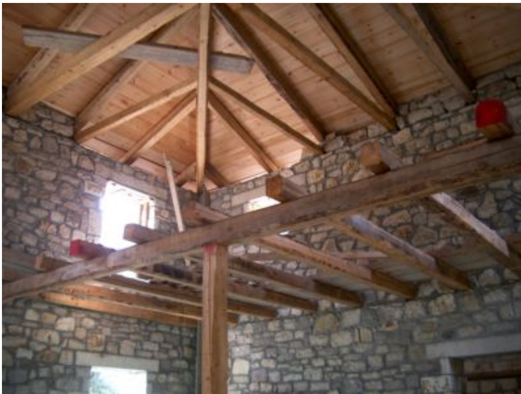
13. Εμφανής κεραμοσκεπή και εσωτερικό πατάρι.
