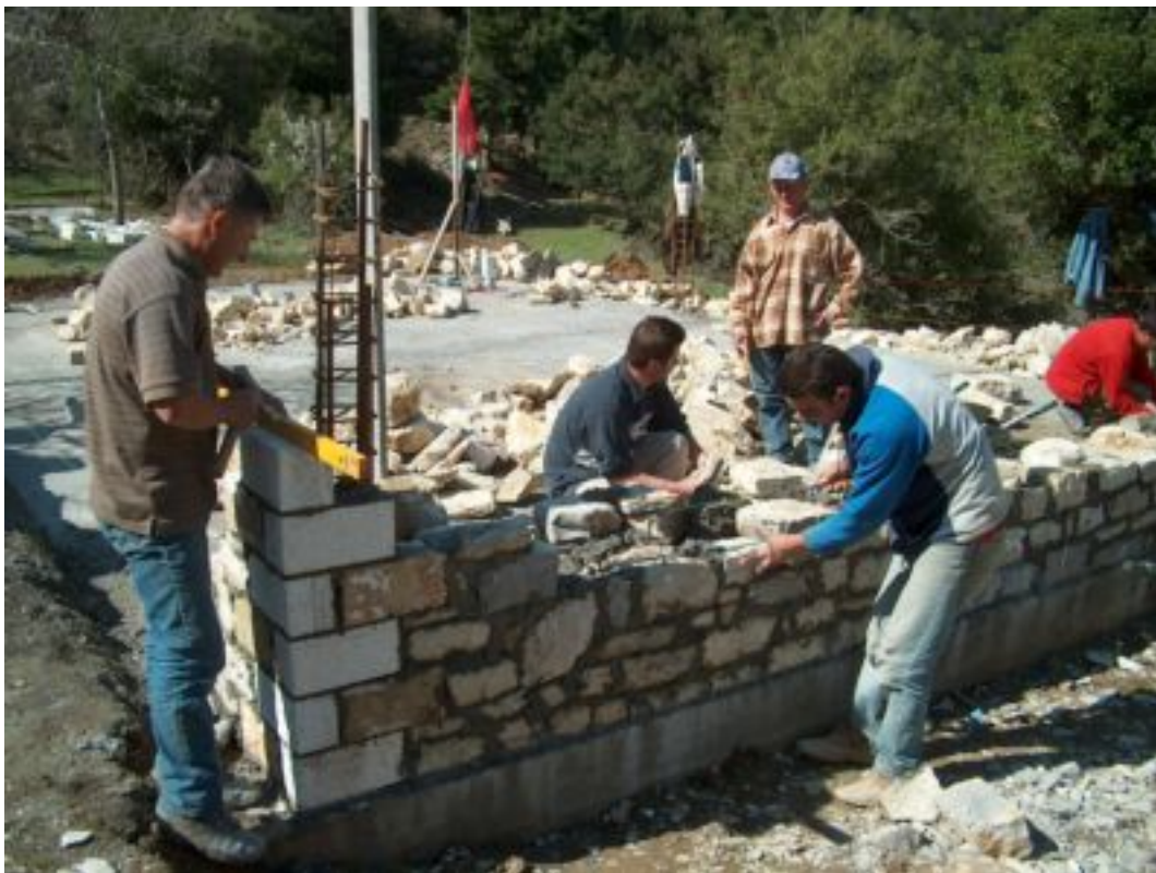
2. Χτίσιμο και Αλφάδιασμα ακρογωνιαίων λίθων.
