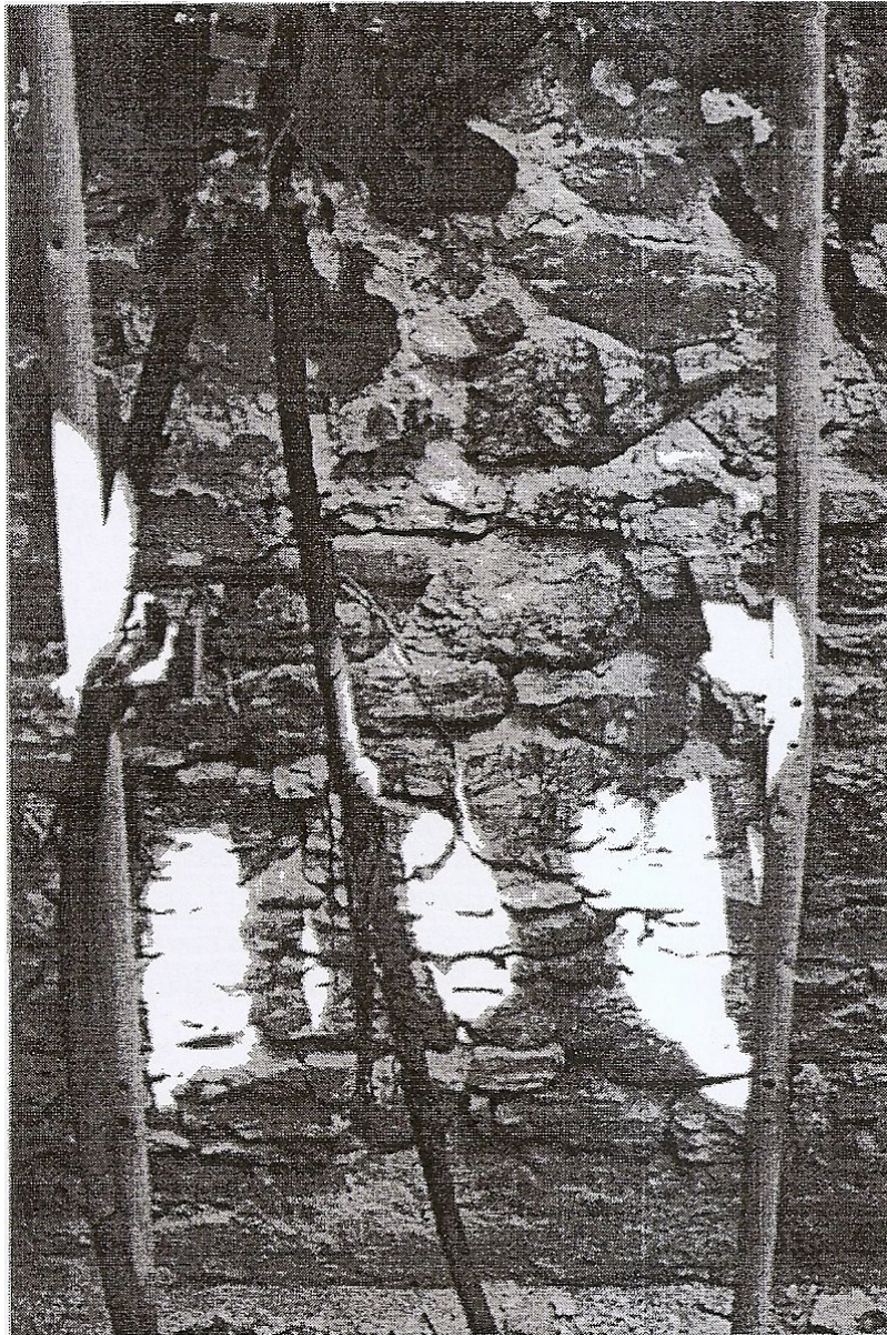
Σχ 8. Απόπλυση κονιάματος χαμηλής αντοχής.
