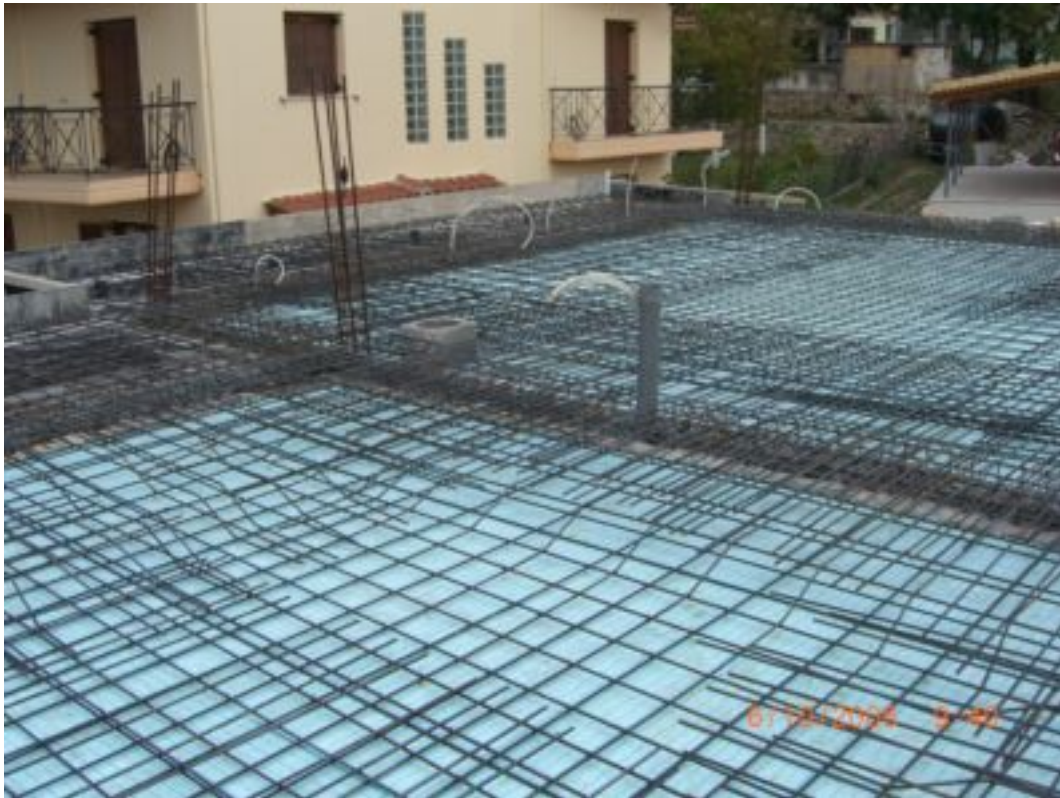
11. Οπλισμός πλάκας ορόφου.
