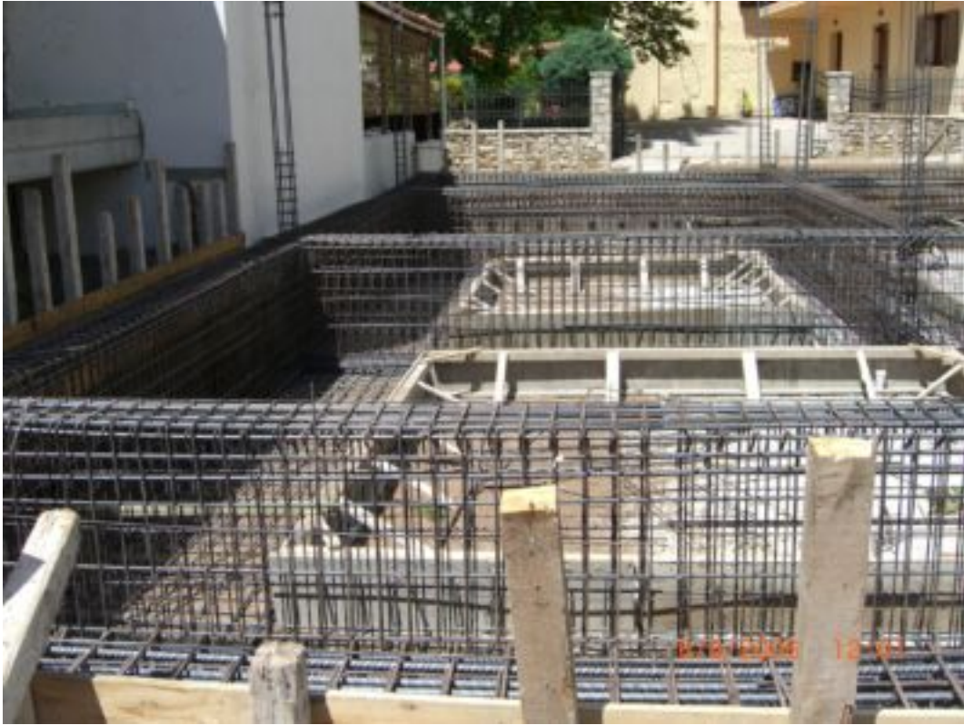
3. Οπλισμός πεδιλοδοκών ( θεμελίωση )
