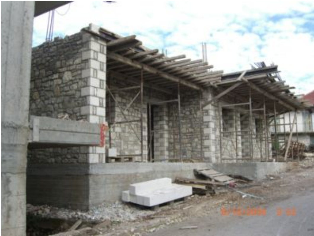
13. Ξυλότυπος πλάκας ορόφου.
