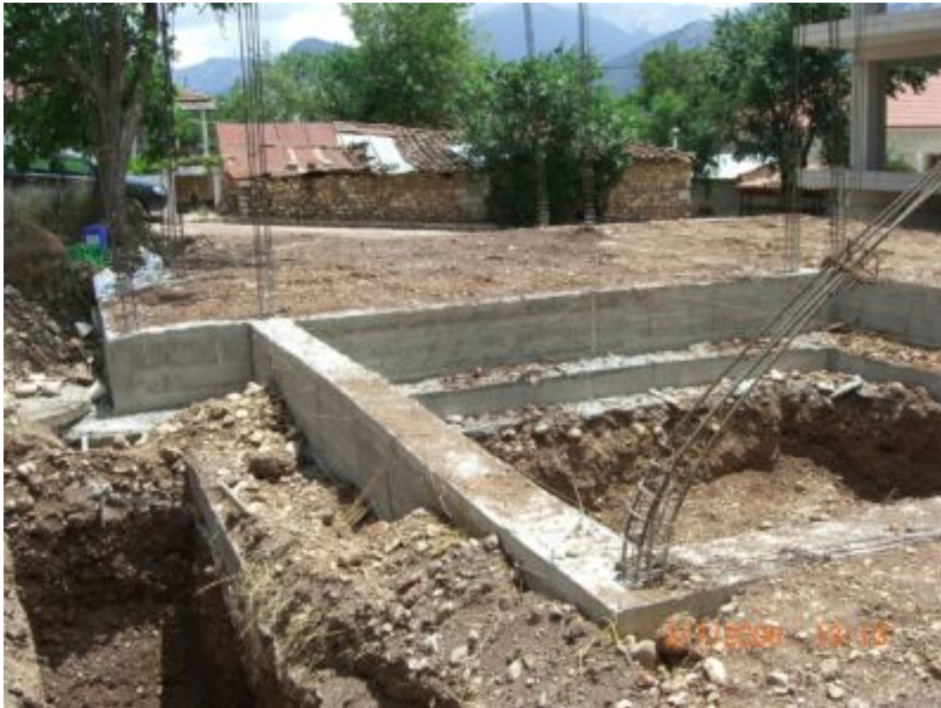
5. Θεμελίωση με τις ειδικές επιχώσεις.
