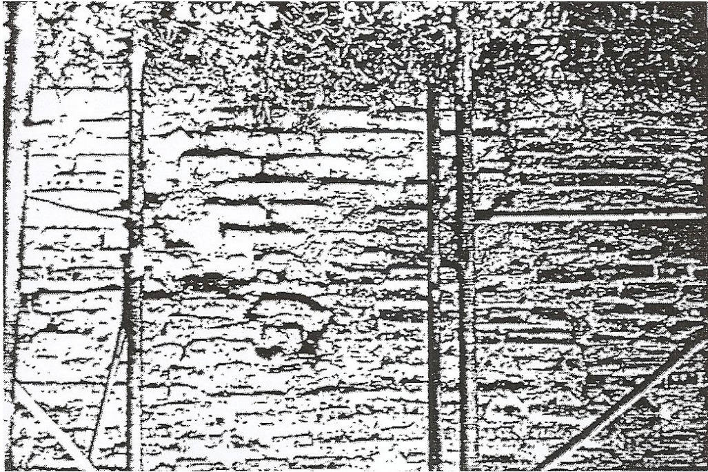
Σχ 6. Η τοπική δράση των υπόγειων υδάτων στην περιοχή της βάσης τοίχου.
