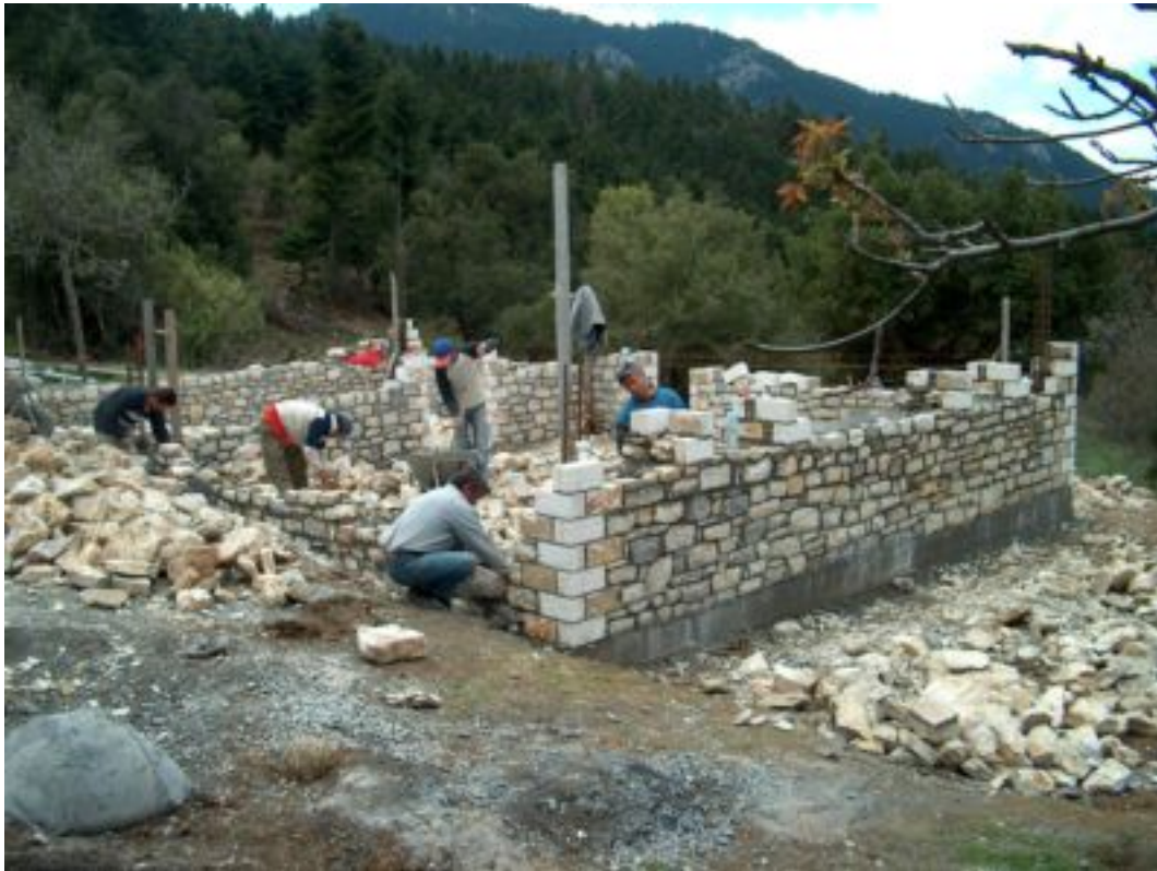
3. Το χτίσιμο γίνεται περιμετρικά.
