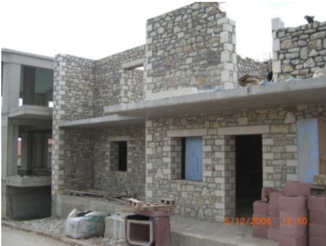
15. Συνέχεια χτισίματος στον όροφο όμοια με εισόγειο.
