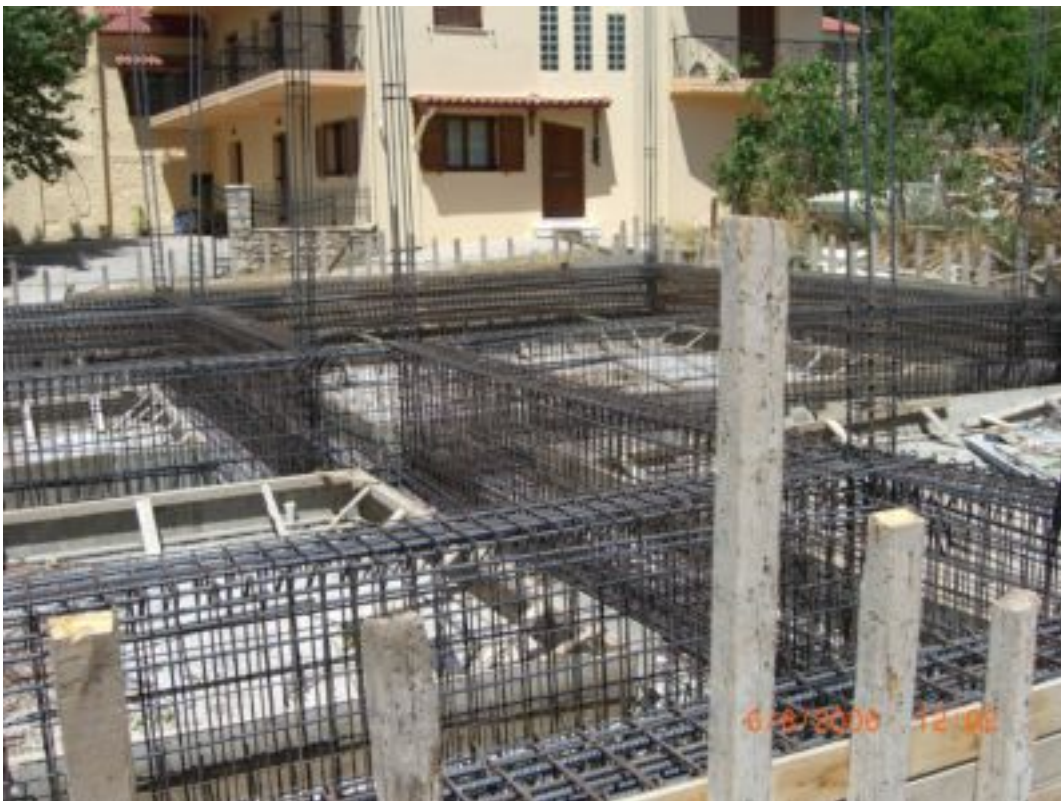
4. Οπλισμός πεδιλοδοκών ( θεμελίωση )
