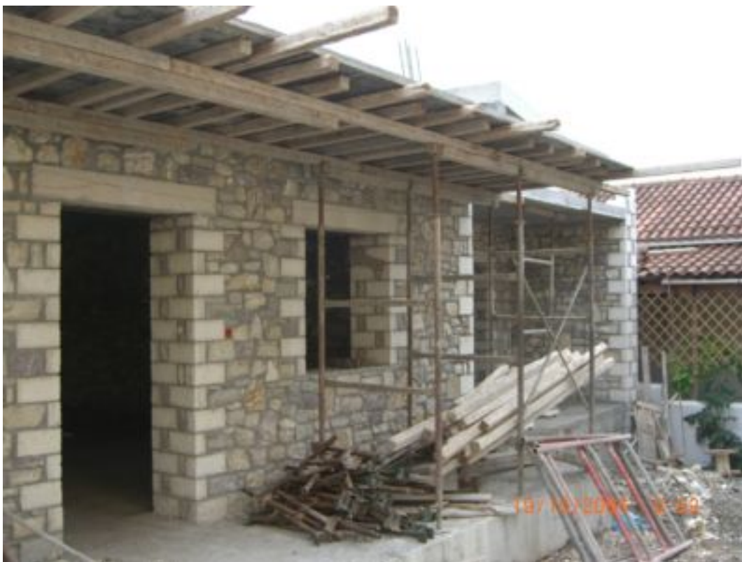
14. Ξυλότυπος πλάκας ορόφου.
