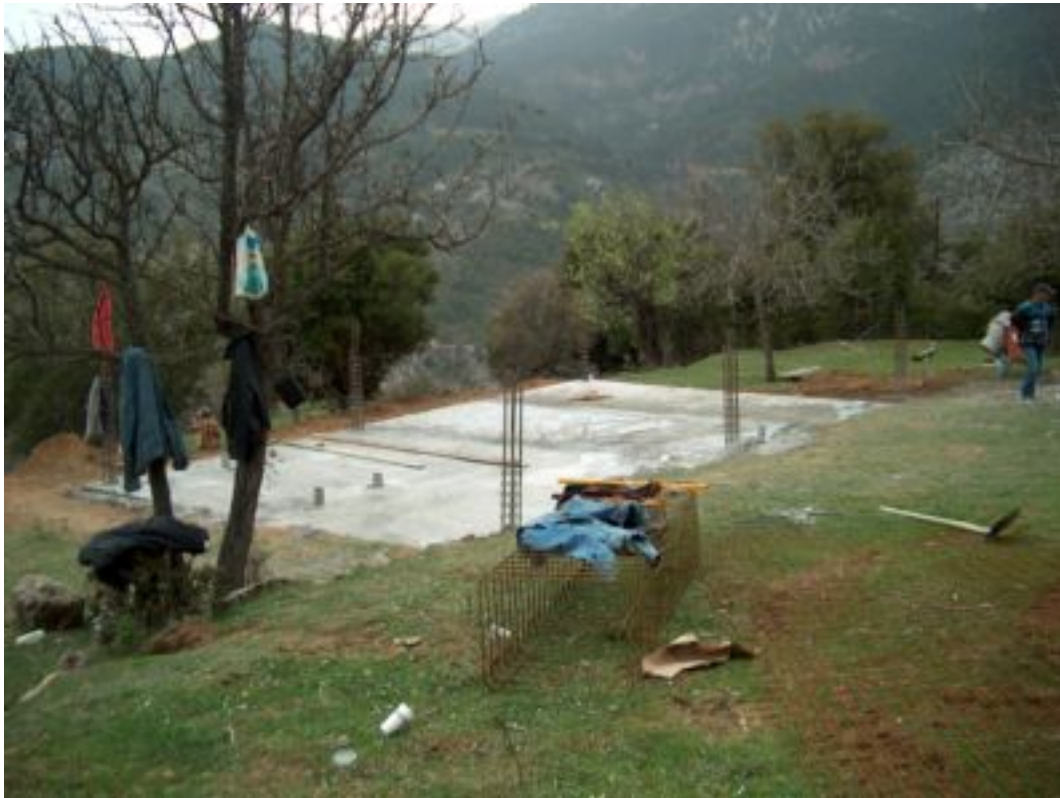
1. Πλάκα Θεμελίωσης.
