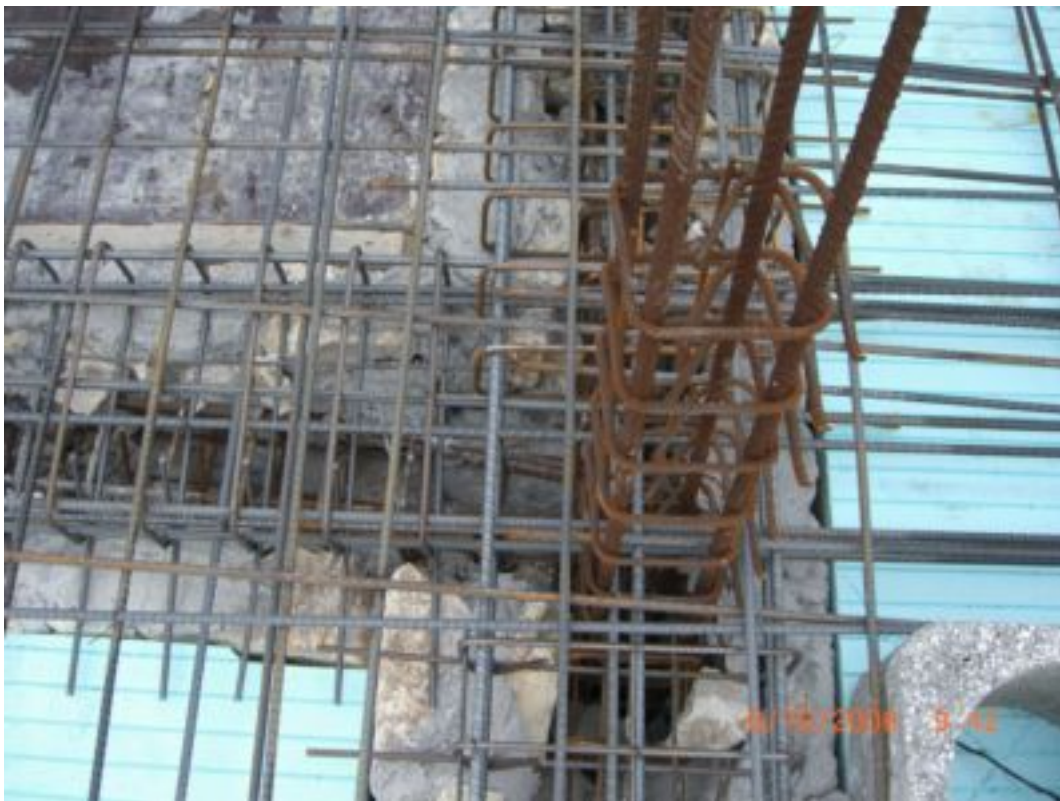
12. Οπλισμός περιμετρικά των φερόντων τοίχων.
