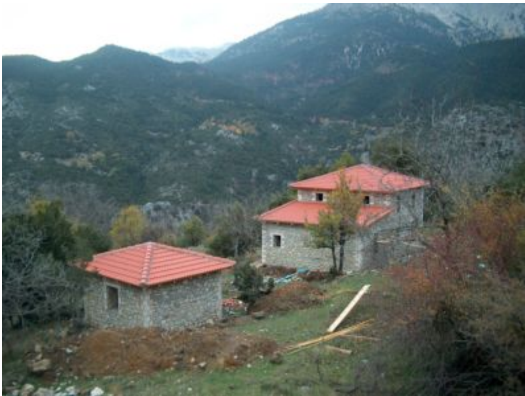
17. Άποψη ολοκληρωμένης κατασκευής
