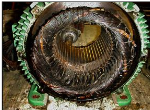
Εικόνα 20 : Αποτέλεσμα στην περιέλιξη ηλεκτρικού κινητήρα έπειτα από σφάλμα υπερθέρμανσης
