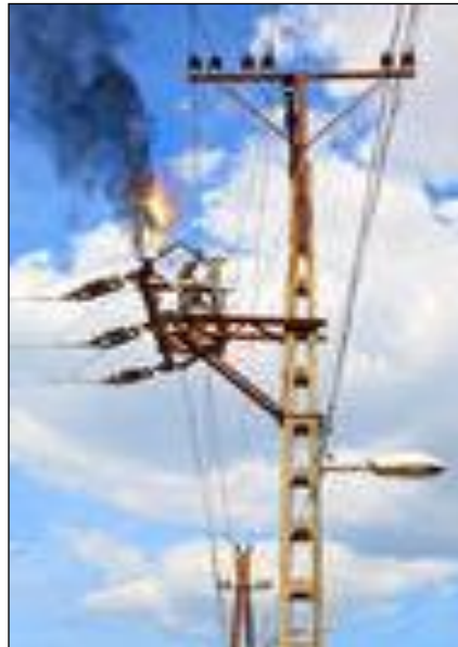
Εικόνα 19 : Αποτέλεσμα βραχυκυκλώματος σε πύλώνα Χ.Τ.
