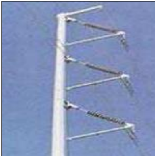
Εικόνα 26: Μονωτήρας τύπου post σε γραμμή μεταφοράς
