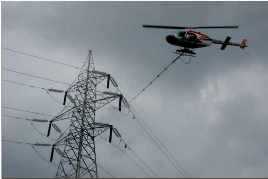
Εικόνα 5 : Συντήρηση γραμμών μεταφοράς
