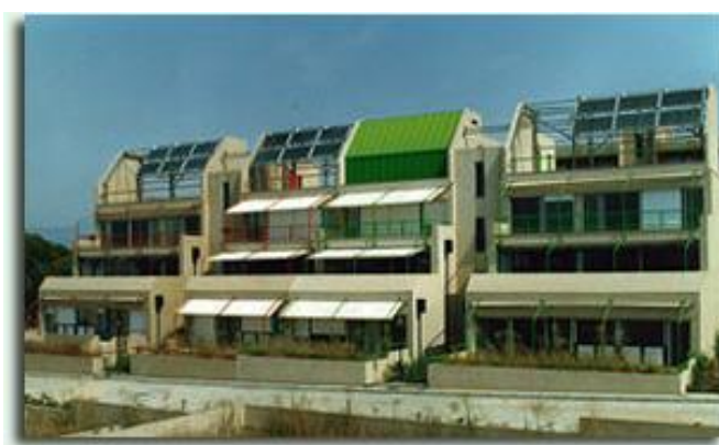
Εικόνα 63: Κτίρια στον ηλιακό χωριό (Πηγή: www.cres.gr )
