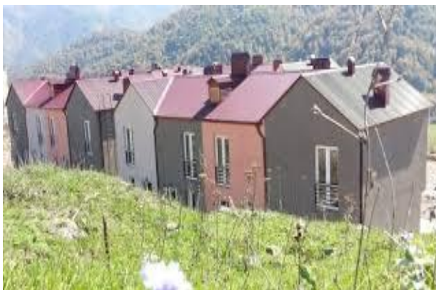
Εικόνα 12: εργατική κατοικία στην Αρμενία (Πηγή: ιστότοπος www.construction.am )
