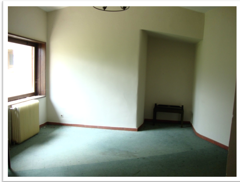
Εικόνα 55: Χώρος εισόδου του εστιατορίου-καφετέριας
