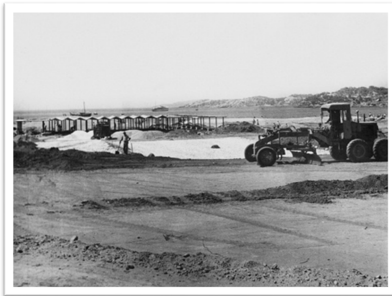
Εικόνα 3: Κατασκευή Ακτή Βουλιαγμένης, 1958-1962
