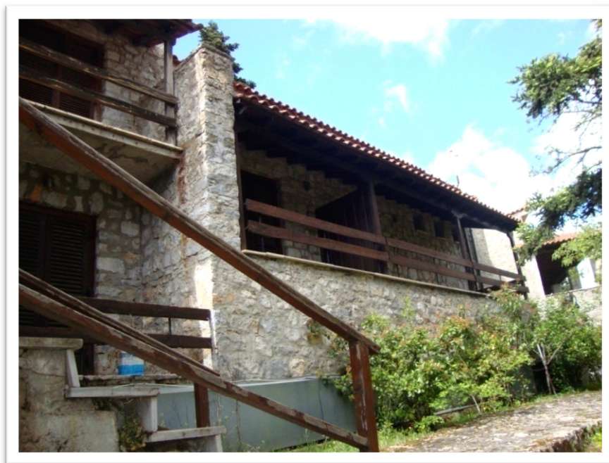
Εικόνα 50: Τμήματα Νοτιοανατολικής όψης
