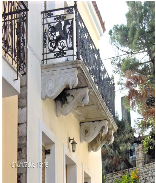
Εικ.25-Κτίριο στο Αλιβέρι με νεοκλασικά χαρ/κά
