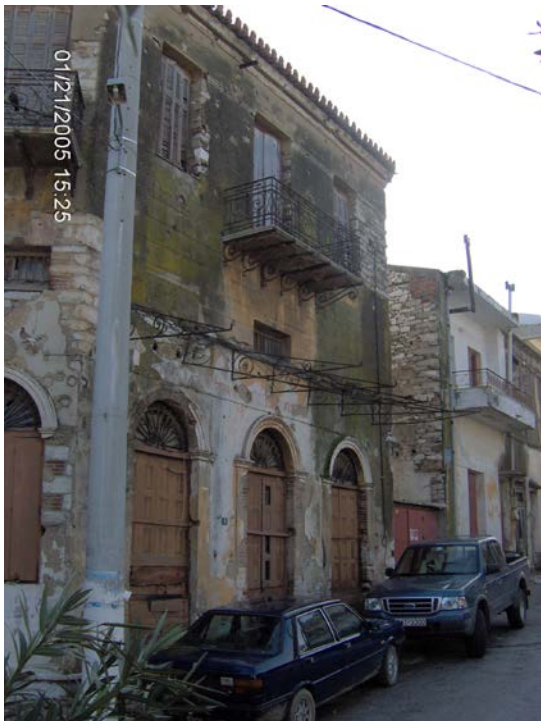
Εικ.24- Διατηρητέο κτίριο στο Αλιβέρι
