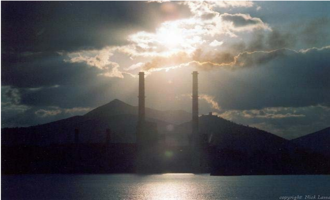
Εικ. 1 : Οι εγκαταστάσεις του ΑΗΣ Αλιβερίου και το Ριζόκαστρο
