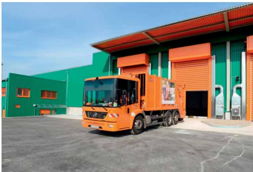
(Εικόνα 21. Μονάδα ζύμωσης βιοαερίου)
