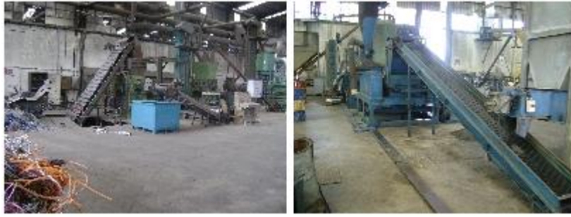
(Εικόνα 18. Εγκαταστάσεις της ΕΛΒΑΝ Α.Β.Ε.Ε.)
