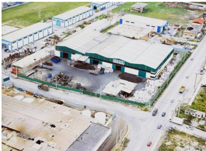
(Εικόνα 17. Εγκαταστάσεις της ΕΛΒΑΝ Α.Β.Ε.Ε.)
