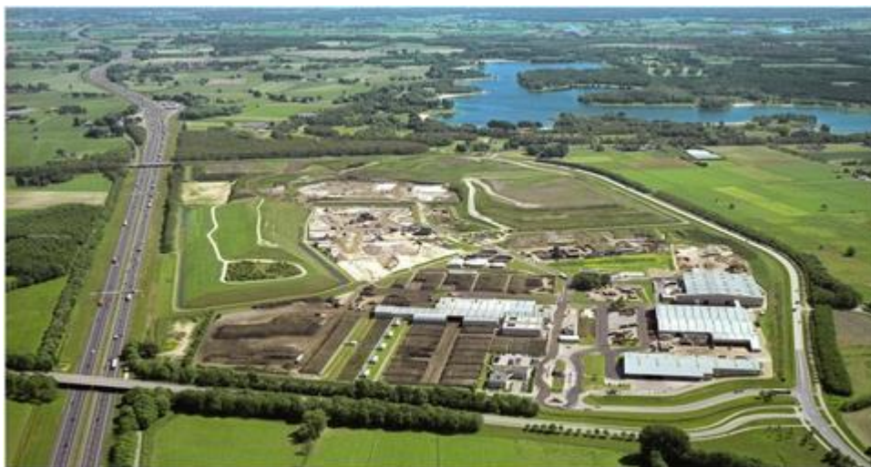
(Εικόνα 29. Εγκαταστάσεις της μονάδας ανακύκλωσης VAR)
