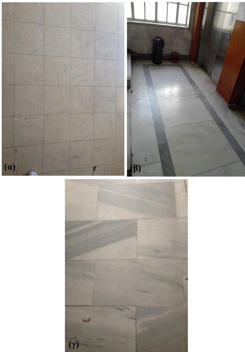
Εικόνα 2: Δάπεδα του κτιρίου. (α) Πλαστικό πλακάκι που υπάρχει σε όλους τους ορόφους του κτιρίου. (β) Μαρμάρινο δάπεδο που βρίσκεται στο πλατύσκαλο μπροστά από τους ανελκυστήρες. (γ) Μαρμάρινο δάπεδο με το οποίο έχει επενδυθεί όλο το ισόγειο του κτιρίου.
