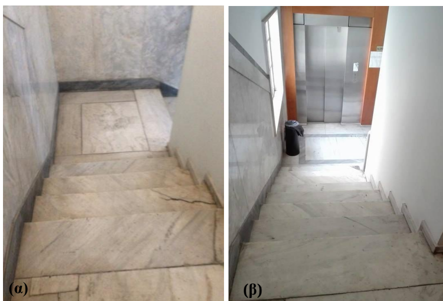
Εικόνα 4: (α) και (β) Κάθοδος μαρμάρινου κλιμακοστασίου.
