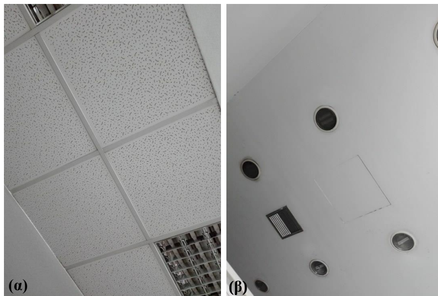
Εικόνα 3: (α) Ψευδοροφή ισογείου και (β) οροφή των υπολοίπων ορόφων του κτιρίου.
