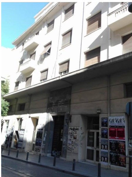
Εικόνα 1: Πρόσοψη του κτιρίου επί της οδού Κολοκοτρώνη 4.
