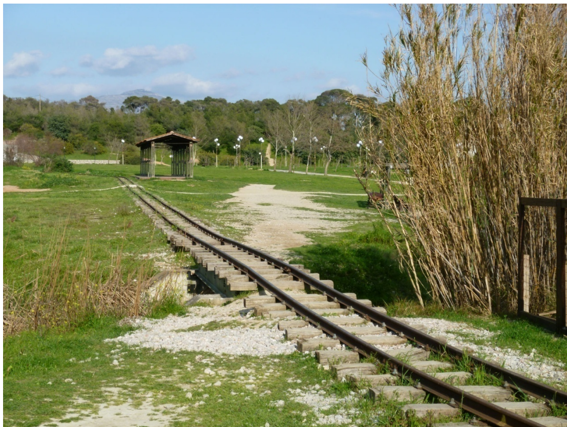
Η σιδηροδρομική γραμμή που κατασκευάστηκε για τη λειτουργία τουριστικού τρένου.
