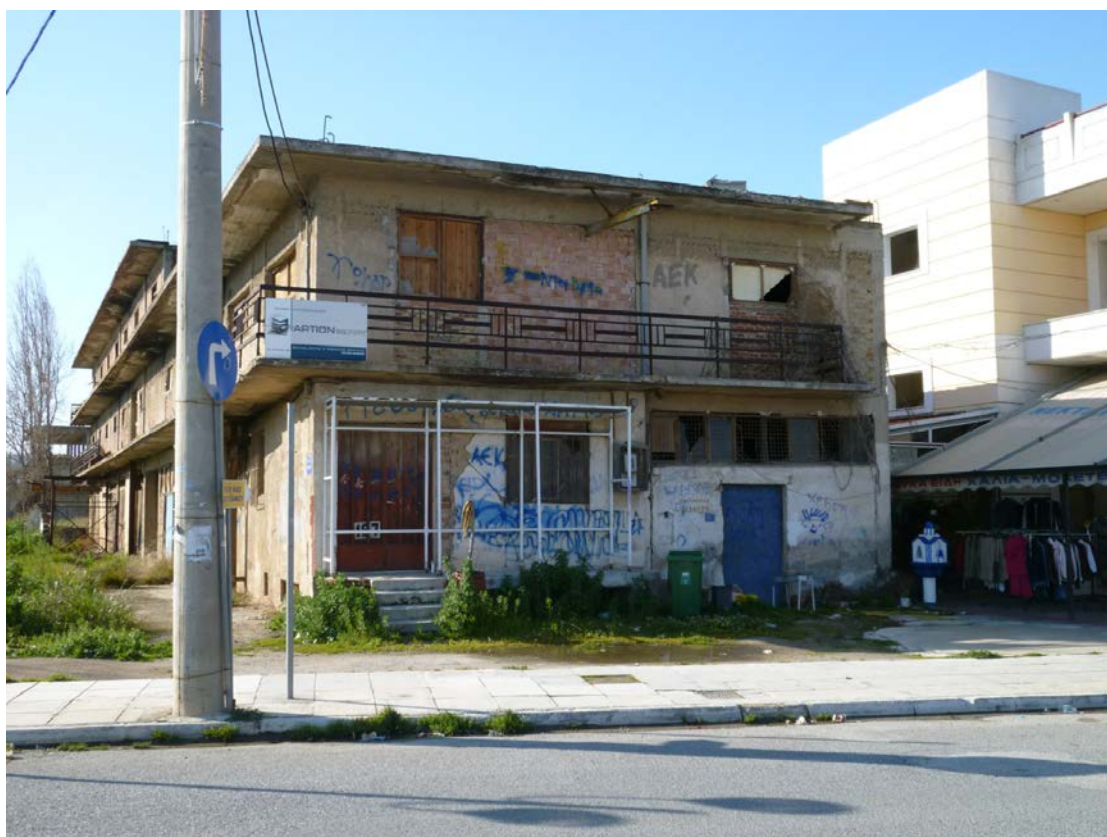
Εγκαταλειμμένο εργοστάσιο και πλάι εμπορικές χρήσεις. Αγίας Γρηγορούσας & Κρυστάλλη
