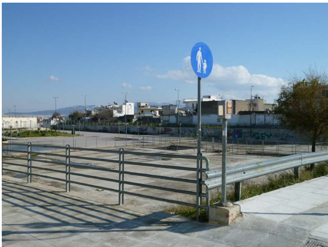
Εικόνα 2.21: Χώρος στάθμευσης & πεζόδρομος πάνω από την Αττική Οδό (γέφυρα)
