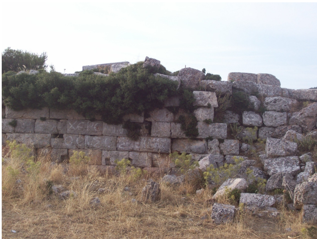
Εικόνα 5.33: Λεπτομέρεια της ισούψους τοιχοδομίας του κάστρου
