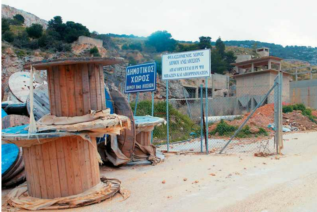
Εικόνα 5.41: Είσοδος λατομείου Μουσαμά. Η ταμπέλα απαγορεύει τη ρίψη μπαζών και απορριμμάτων, απορρίπτονται όμως λύματα.
