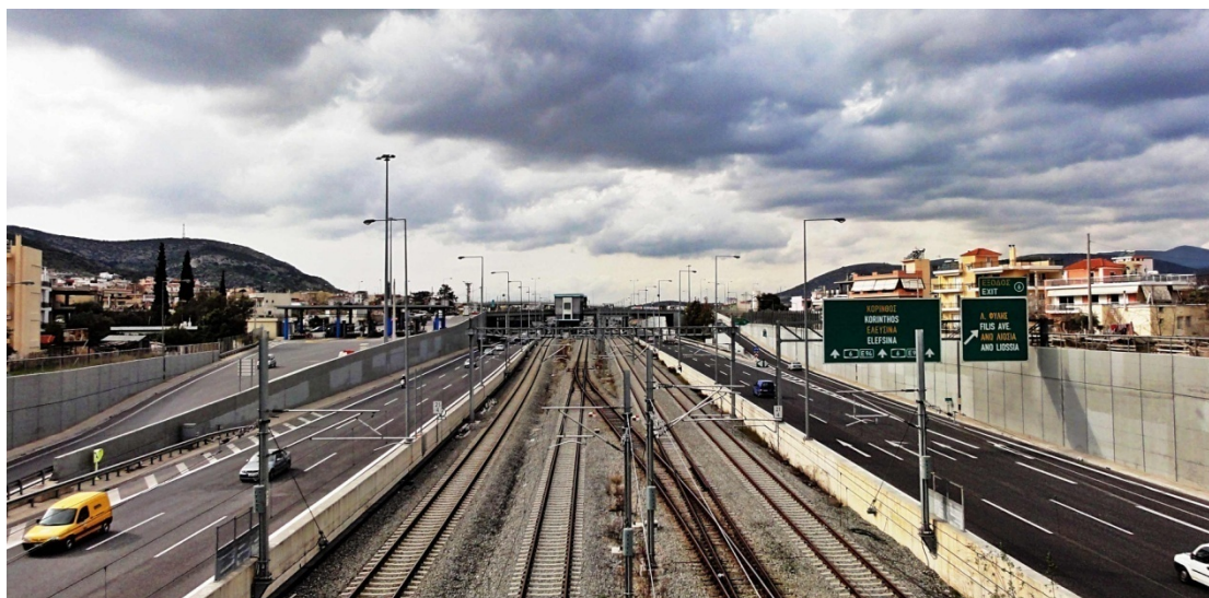
Εικόνα 2.7: Αττική Οδός, σιδ/κές γραμμές Προαστιακού & σταθμός Άνω Λιοσίων ΠΗΓΗ: Google Earth (διαδίκτυο)
