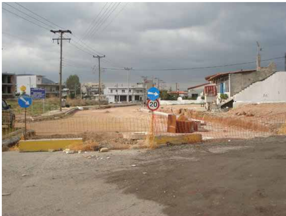
Εικόνα 2.15: Έργα οδοποιίας που έχουν πλέον ολοκληρωθεί ΠΗΓΗ: http://www.local-news.gr
