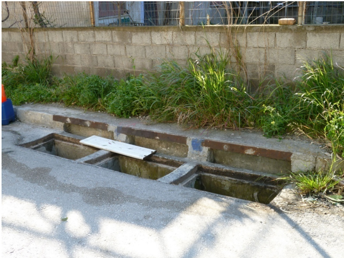
Εικόνα 2.17: Σε αρκετά σημεία του δικτύου αποχέτευσης ομβρίων οι σχάρες λείπουν
