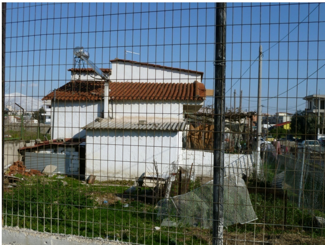
Κατοικίες τσιγγάνων επί της Παναγίας Γρηγορούσας στο ύψος της οδού Παπανικολή (Π.Ε.1)
