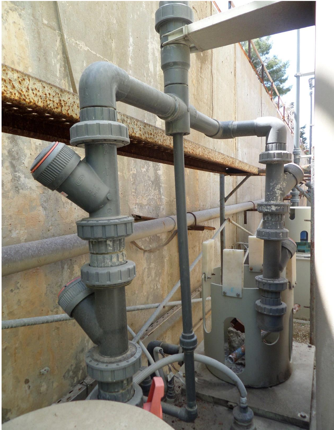
Εικόνα 47 Η μια αντλία έχει αφαιρεθεί για συντήρηση . Μέσα στις σωλήνες υπάρχει μια ανεπίστροφη βαλβίδα και ένα φίλτρο
