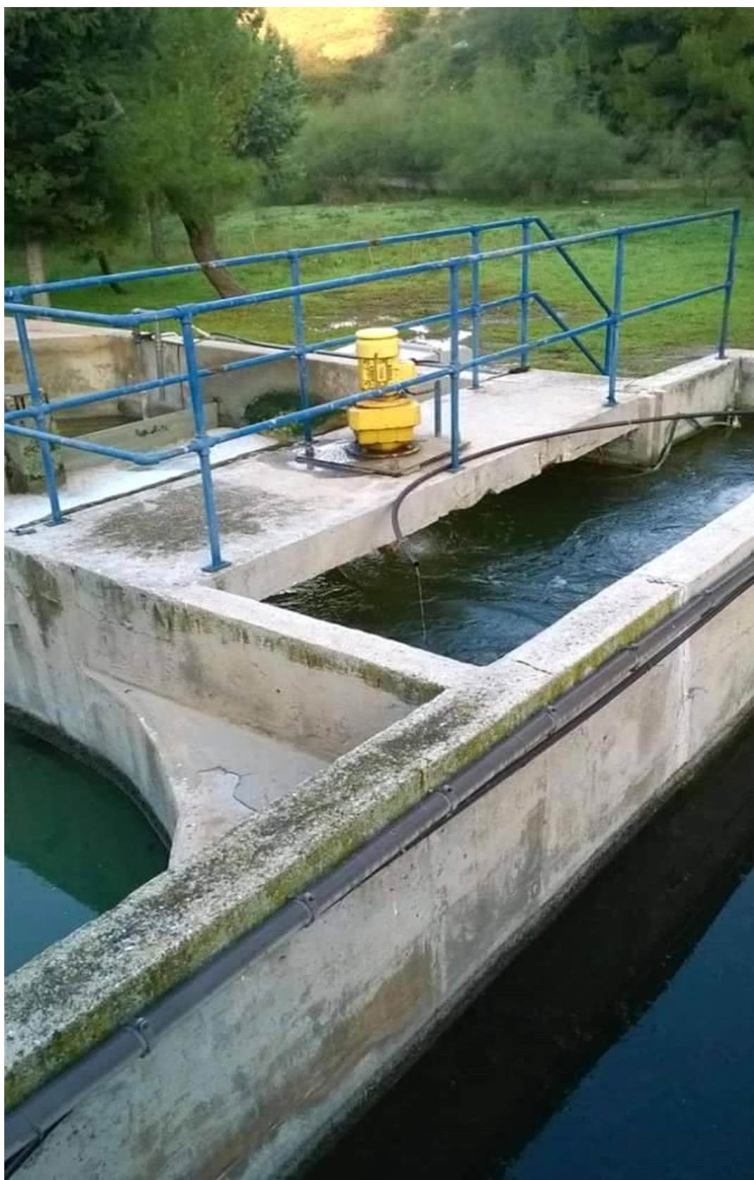
Εικόνα 29 Σημείο περίχυσης χλωρίου
