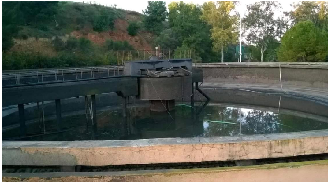
Εικόνα 22 Ξέστρο δεξαμενής
