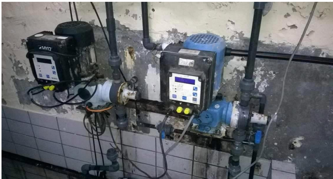
Εικόνα 27 Δοσομετρικές αντλίες
