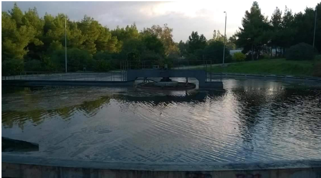
Εικόνα 21 Ξέστρο δεξαμενής
