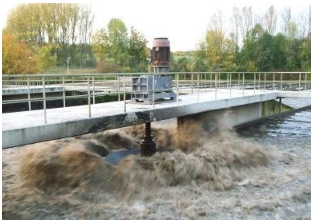
Εικόνα 14 Επιφανειακός Αεριστήρας
