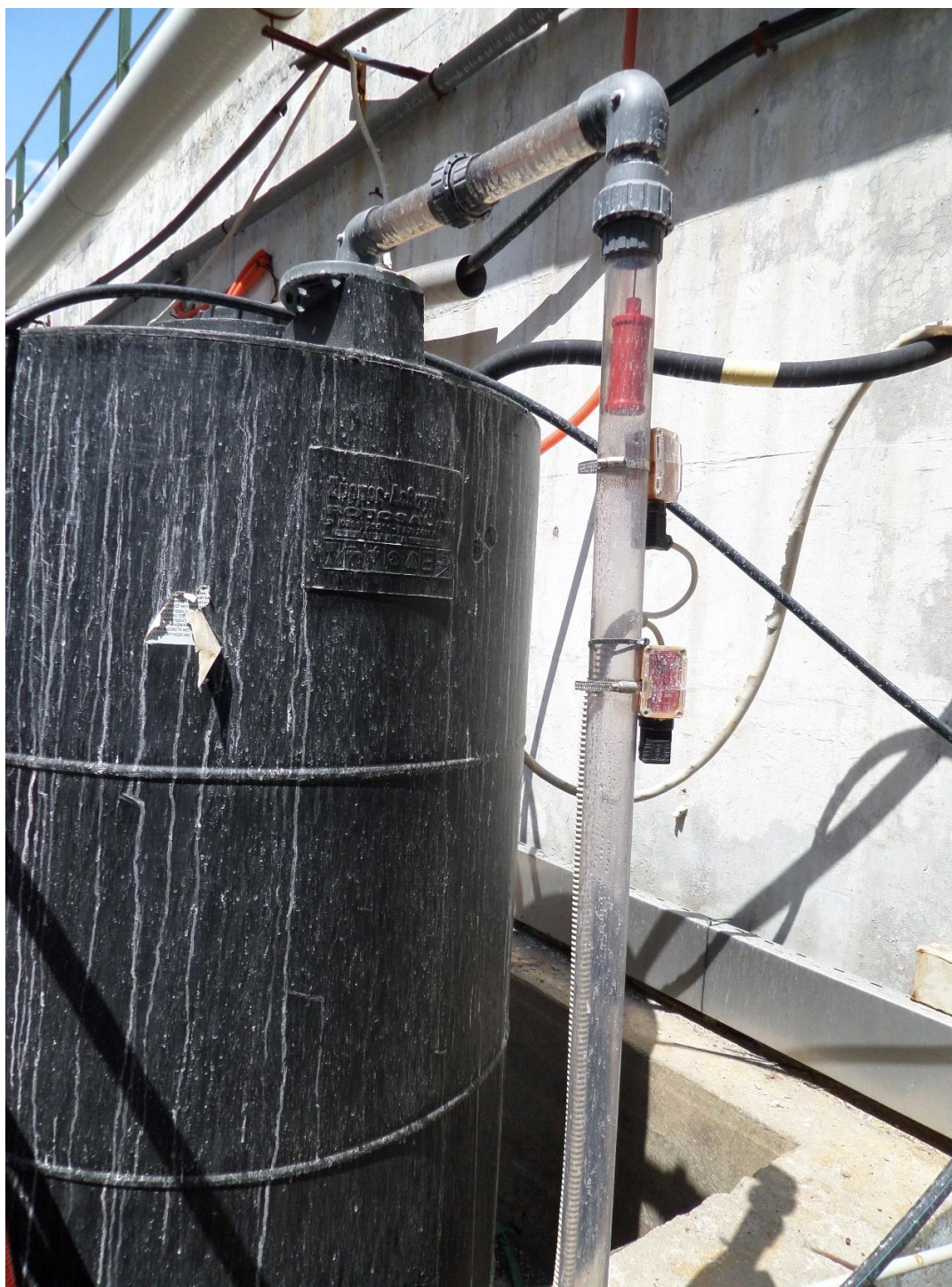
Εικόνα 40 Φλοτέρ δεξαμενής
