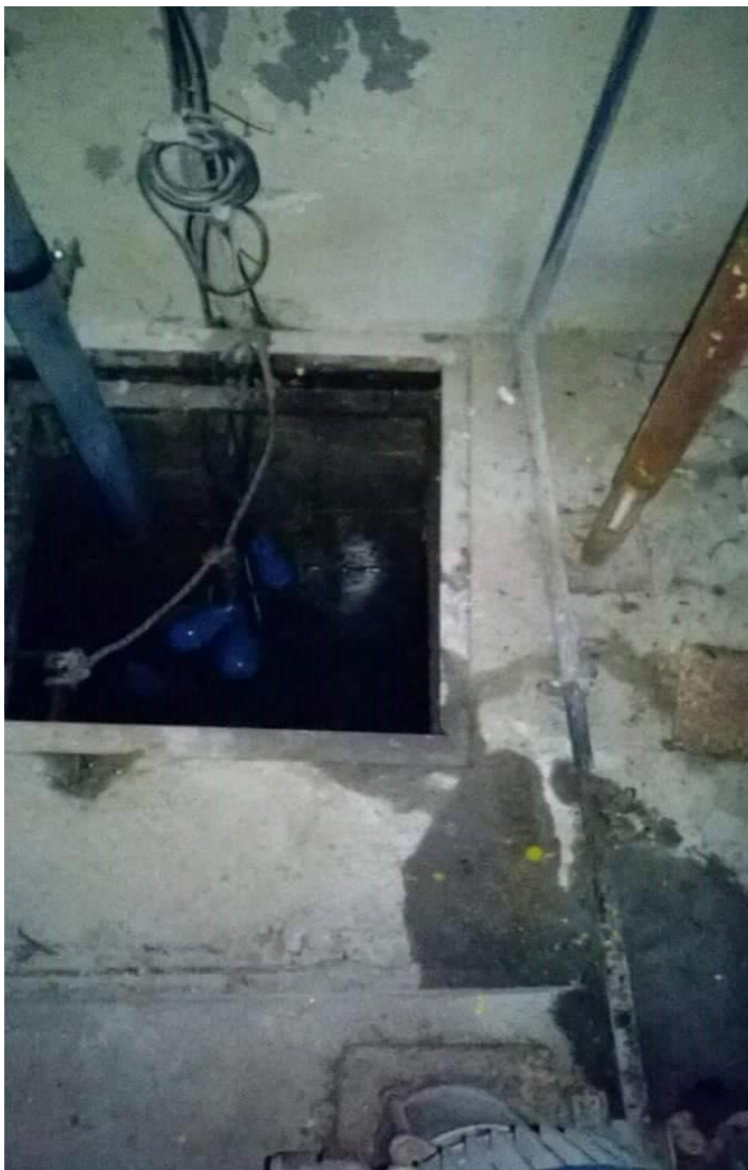
Εικόνα 36 Δεξαμενή βιομηχανικού νερού
