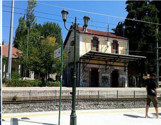
Ο σιδηροδρομικός σταθμός ΟΣΕ στον Αγ. Στέφανο
