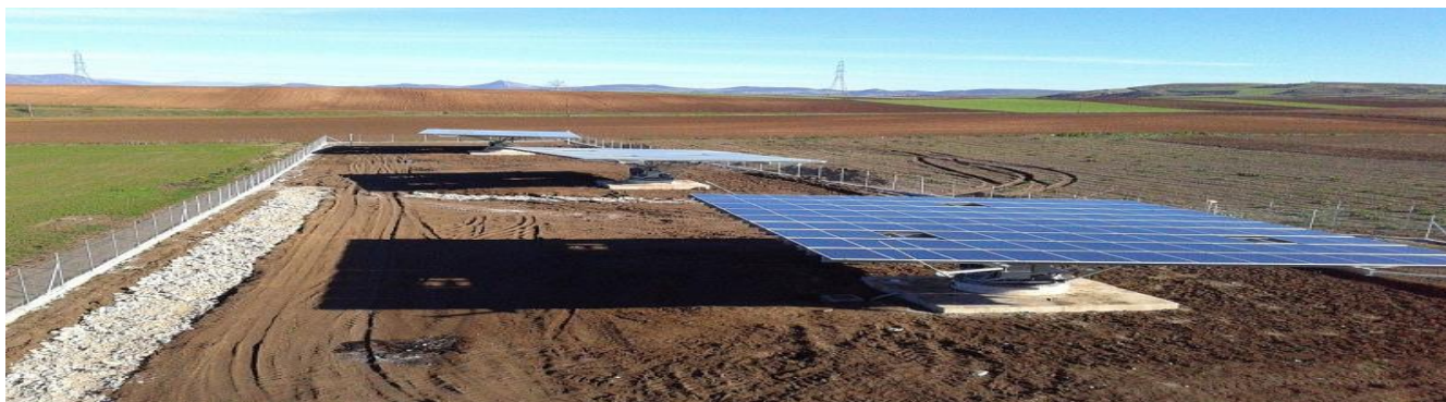
Εικόνα 20 "Συστήμα ιχνηλατήσεις του ήλιου μονού άξονα" (Σύνδεσμος Εταιρειών Φωτοβολταϊκών. Ένας Πρακτικός Τεχνικός Οδηγός. Νοέμβριος 2010. )
