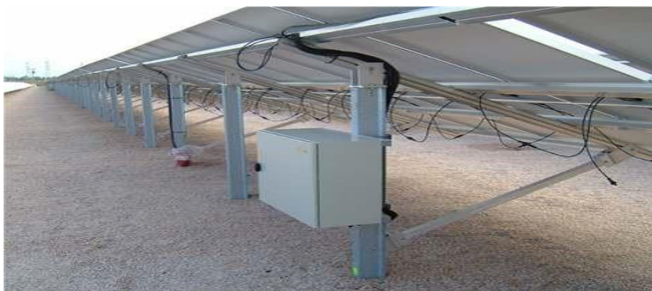
Εικόνα 18 "Εδαφόμενη σταθερή βάση" (Σύνδεσμος Εταιρειών Φωτοβολταϊκών. Ένας Πρακτικός Τεχνικός Οδηγός. Νοέμβριος 2010. )
