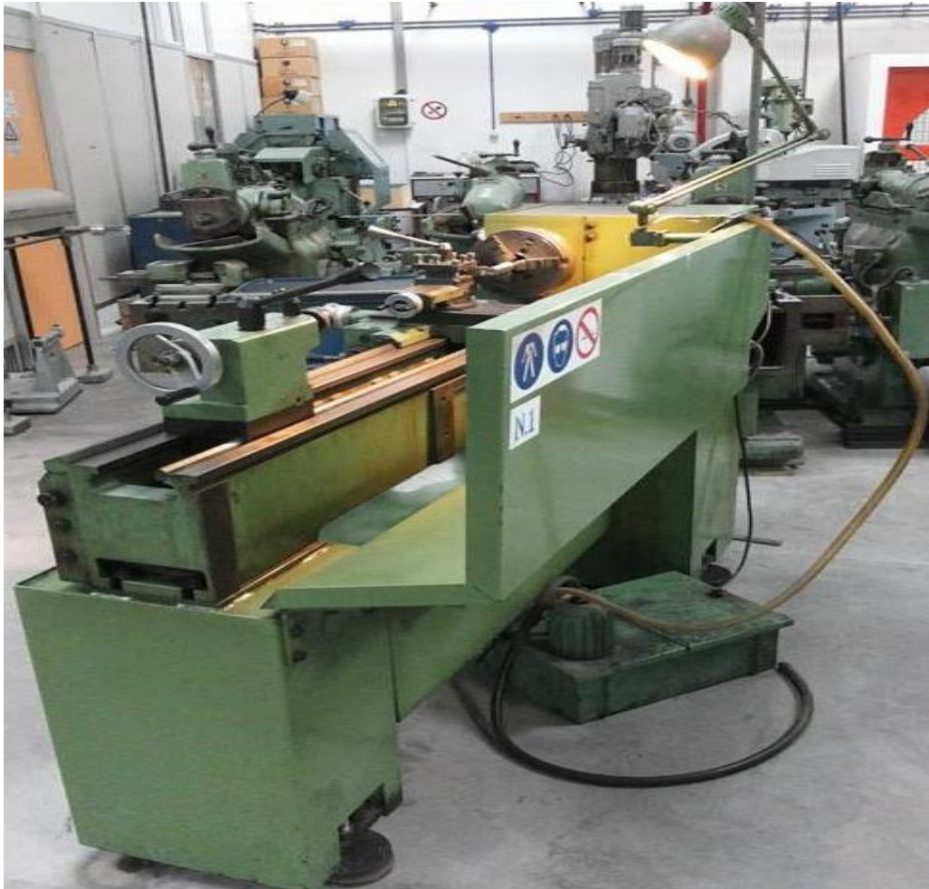
Εικόνα 4.23 Αποκατάσταση συστήματος φωτισμού και ψύξης στον τόρνο νούμερο 1.
