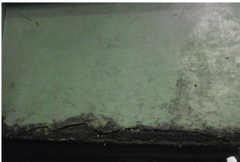
Εικόνα 4.22 Ράγισμα εξωτερικής επιφάνειας της λεκάνης με το υγρό ψύξης.
