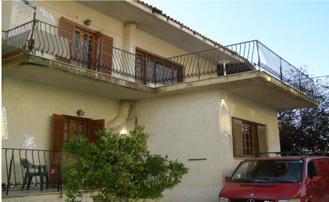
Φ2 ΒΟΡΕΙΟΑΝΑΤΟΛΙΚΗ ΟΨΗ ΚΑΤΟΙΚΙΑΣ ΣΤΟ ΑΡΓΟΛΙΚΟ ΝΑΥΠΛΙΟΥ
