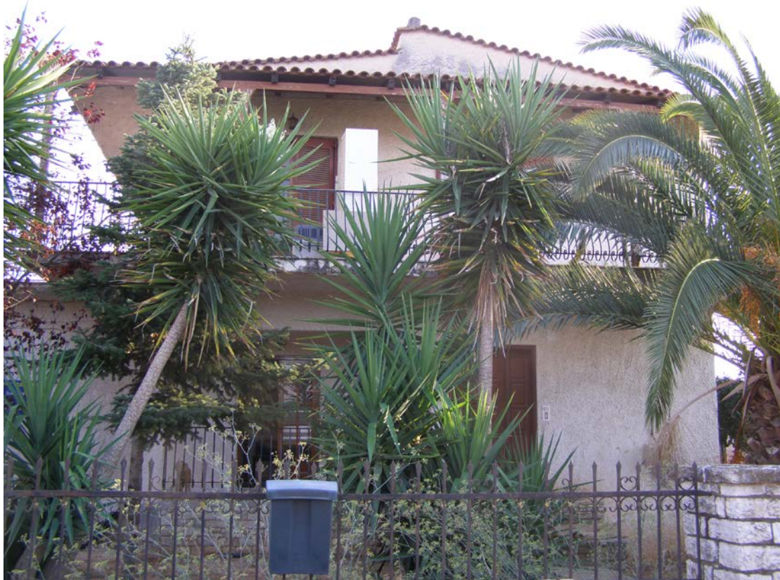
Φ1 ΒΟΡΕΙΟΔΥΤΙΚΗ ΟΨΗ ΚΑΤΟΙΚΙΑΣ ΣΤΟ ΑΡΓΟΛΙΚΟ ΝΑΥΠΛΙΟΥ
