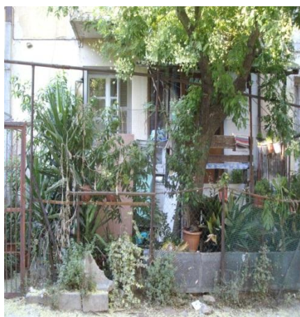
Εικόνα 20. ΝΟΤΙΑ ΟΨΗ ΚΤΙΡΙΟΥ 8
