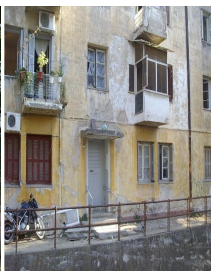
Εικόνα 15.ΝΟΤΙΑ ΟΨΗ ΚΤΙΡΙΟΥ 6 (ΔΙΑΜΟΡΦΩΣΗ ΠΡΟΒΟΛΟΥ ΣΕ ΚΑΤΑΣΚΕΥΗ ΚΛΕΙΣΤΟ ΤΥΠΟΥ)
