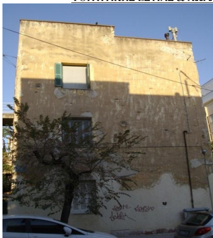
Εικόνα 22. ΔΥΤΙΚΗ ΟΨΗ ΚΤΙΡΙΟΥ 7.
