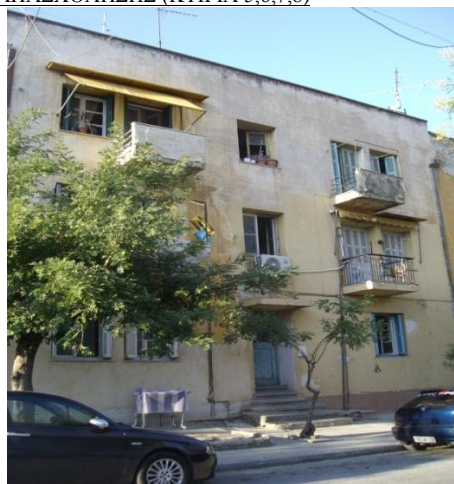
Εικόνα 23. ΝΟΤΙΑ ΟΨΗ ΚΤΙΡΙΟΥ 7
