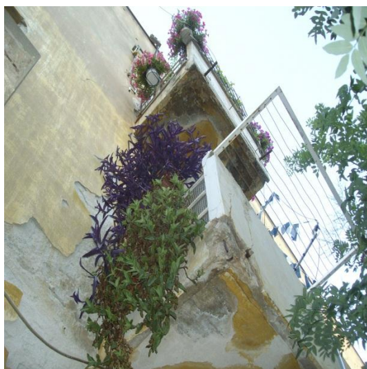
Εικόνα 6. ΝΟΤΙΑ ΟΨΗ ΚΤΙΡΙΟΥ 5.
