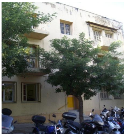
Εικόνα 24. ΝΟΤΙΑ ΟΨΗ ΚΤΙΡΙΟΥ 7
