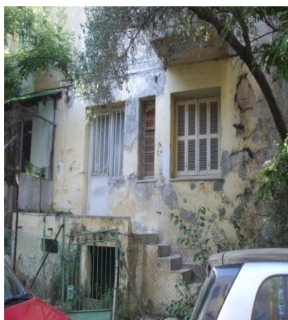
Εικόνα 19. ΝΟΤΙΑ ΟΨΗ ΚΤΙΡΙΟΥ 8
