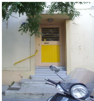
Εικόνα 25. ΝΟΤΙΑ ΟΨΗ ΚΤΙΡΙΟΥ 7.
