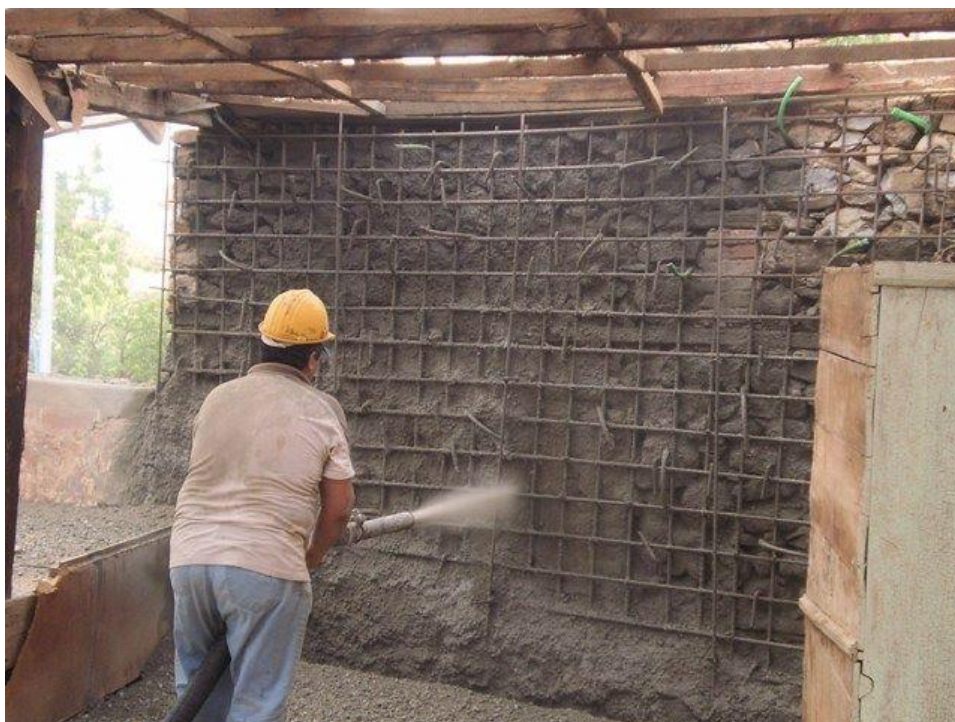
Εικ. 23 :Ενίσχυση με μανδύα οπλισμένου σκυροδέματος
