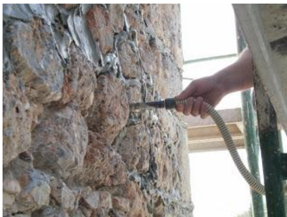
Εικ.24 :Ενίσχυση της τοιχοποιίας με την μέθοδο των τσιμεντενέσεων
