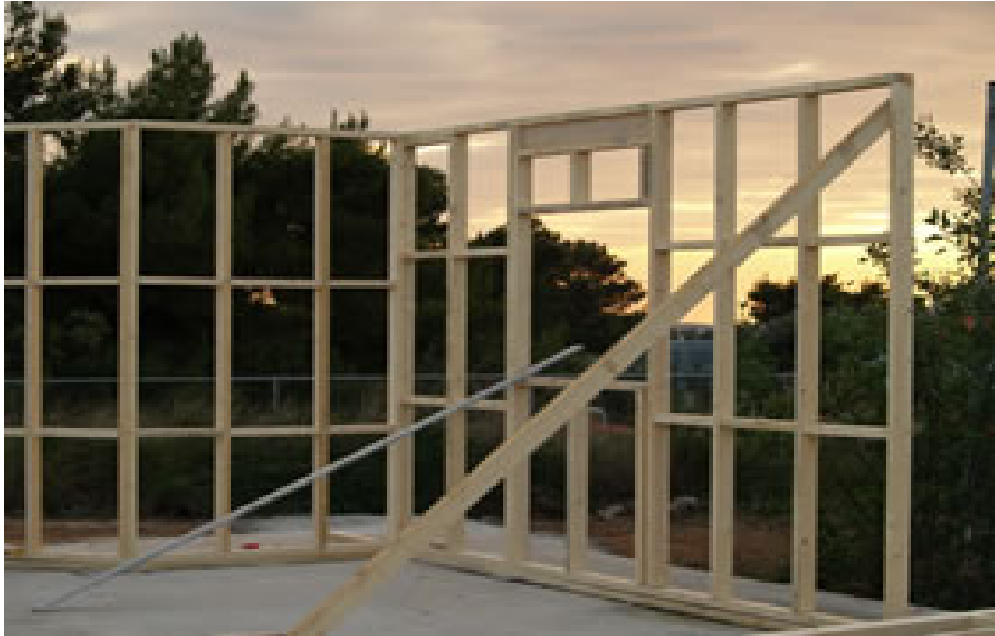
Εικόνα 40 Ορθοστάτες συνδεόμενοι με τραβέρσες
