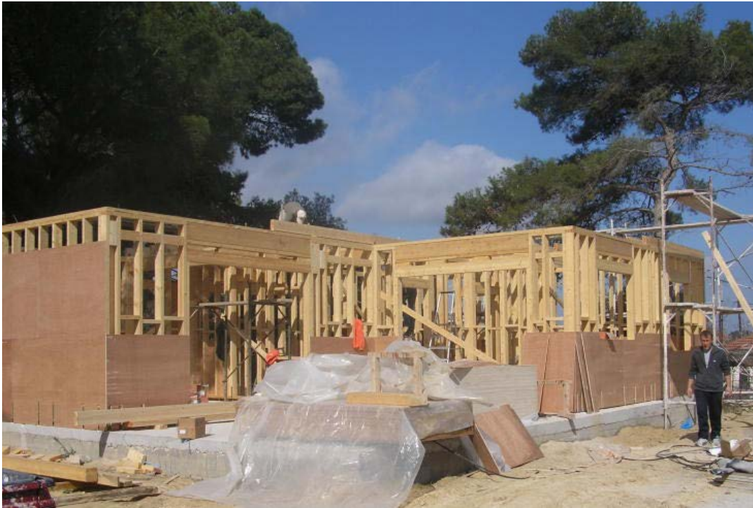
Εικόνα 38 Στάδια κατασκευής ξύλινης κατοικίας
