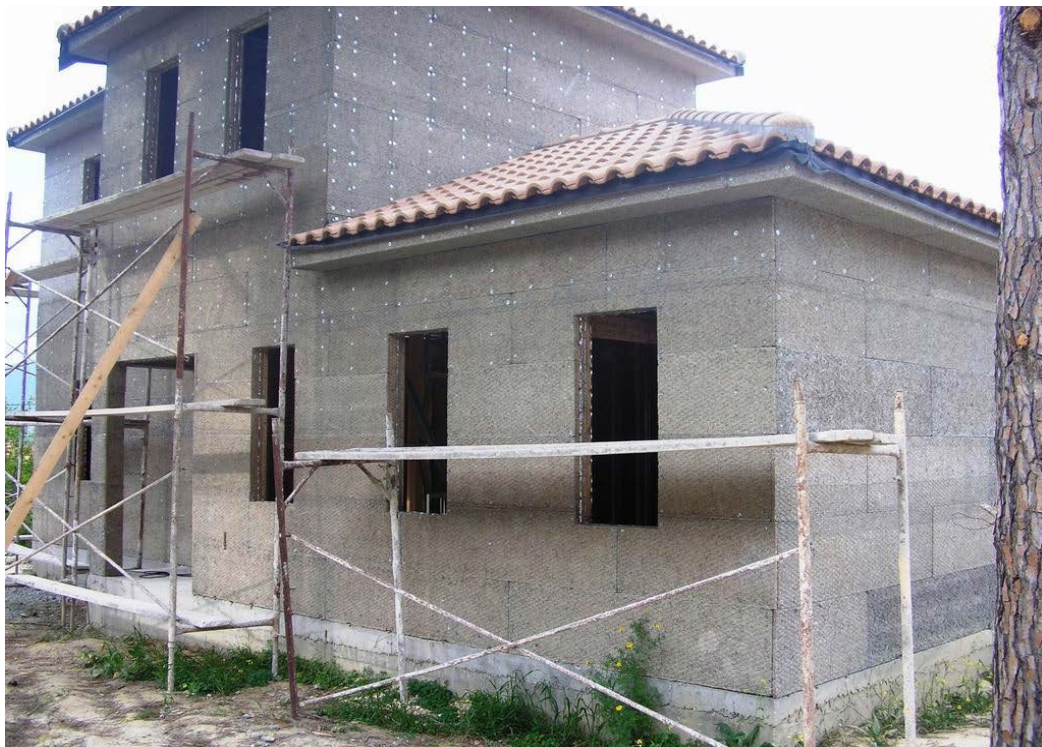
Εικόνα 39 Στάδια κατασκευής ξύλινης κατοικίας
