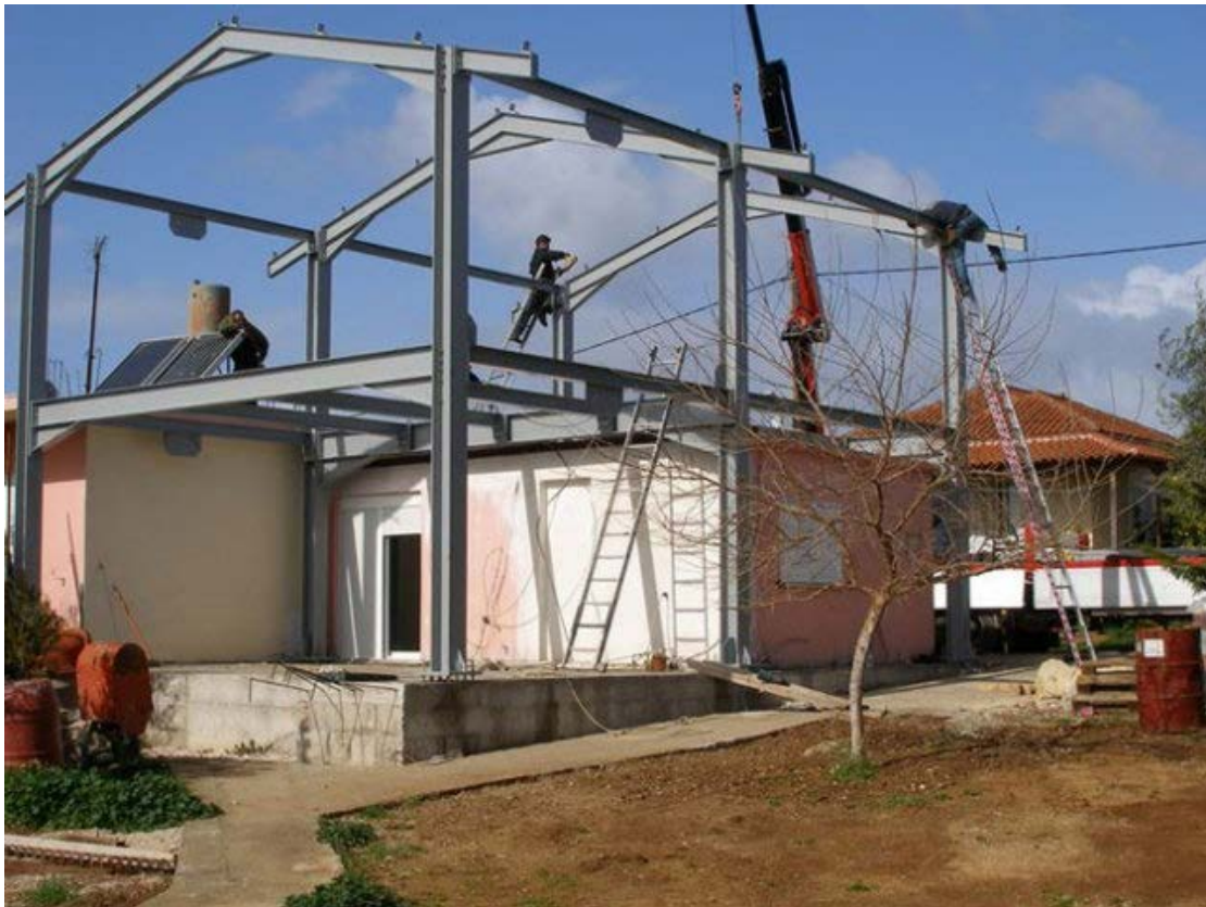
Εικόνα 33 Στάδια συναρμολόγησης σύμμεικτης κατασκευής (α)
