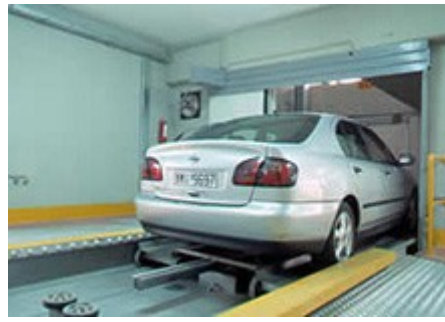
εικόνα 8: μηχανισμός σε λειτουργία κατά την παραλαβή του οχήματος
