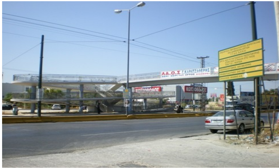
εικόνα 1: Πεζογέφυρα οδού Πέτρου Ράλλη
