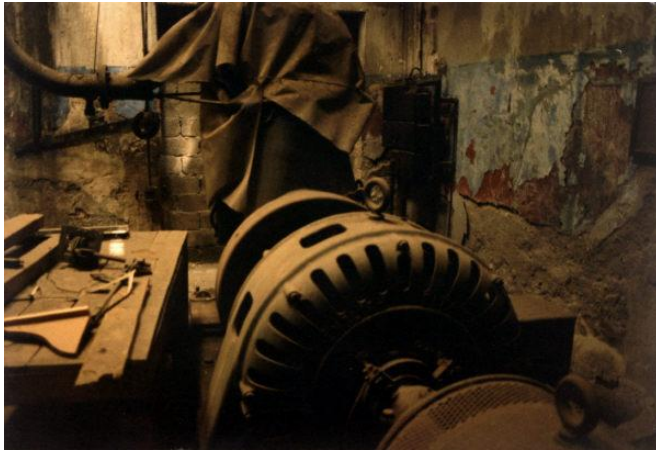
Εικόνα 10: Τουρμπίνα στο Βυρσοδεψείο Σουρλάγκα
