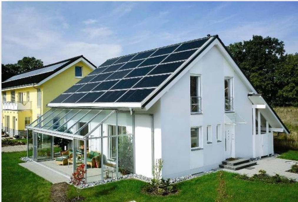
Εικόνα 1.4.2 Αυτόνομο φωτοβολταϊκό σύστημα σε στέγη
