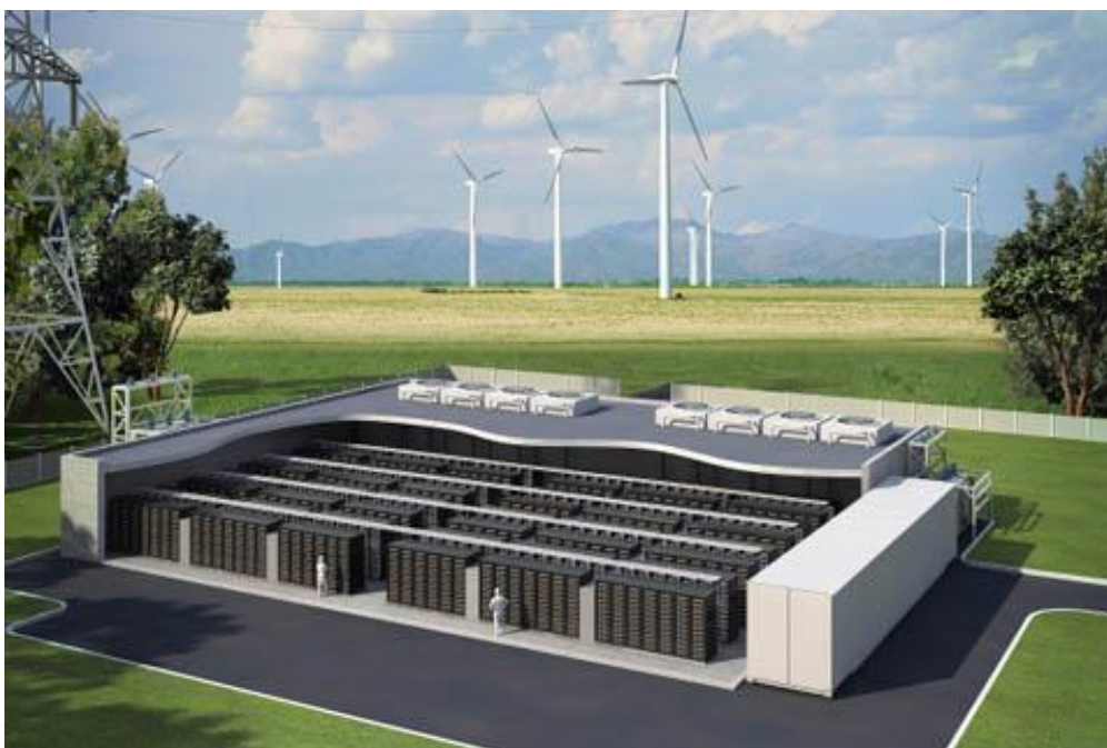
Εικόνα 2.3 Αιολικό πάρκο με σύστημα αποθήκευσης ενέργειας
