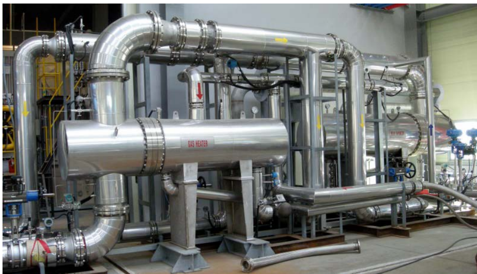
Θερμαντήρες εξαναγκασμένης εξάτμισης υγροποιημένου φυσικού αερίου
