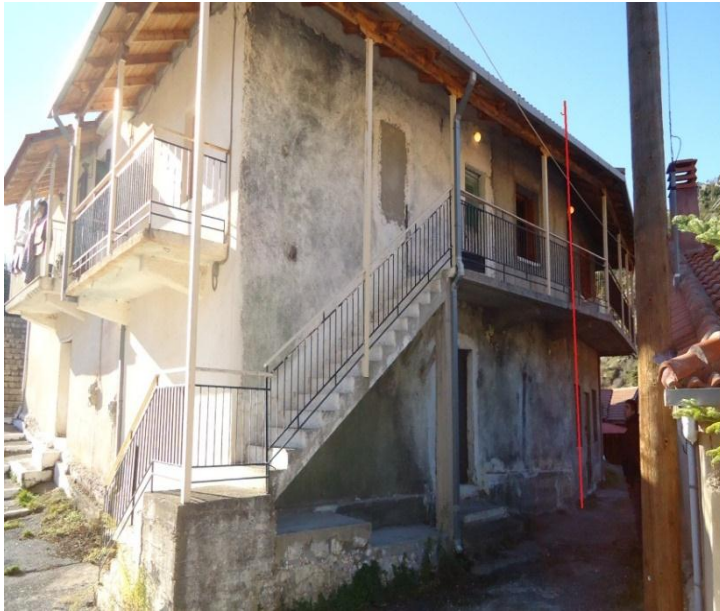
Εικόνα 29: Βορεινή πλευρά κατοικίας
