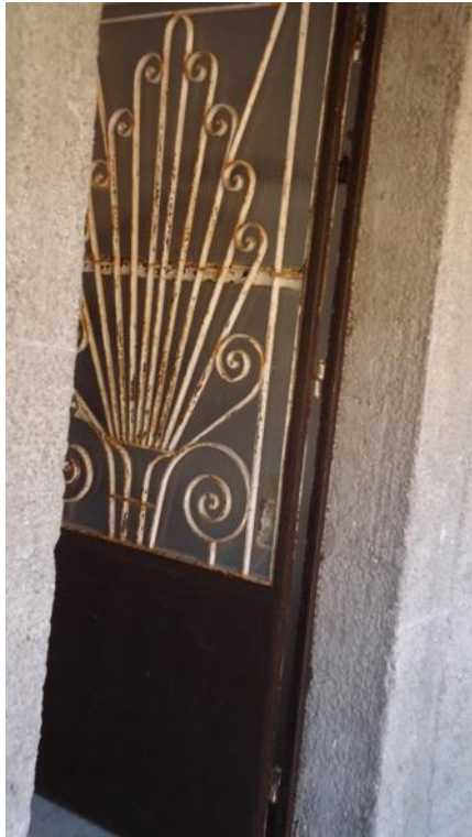
Εικόνα 33 : Η μετέπειτα πόρτα της κατοικίας είναι σιδερένια με διαστάσεις 1,25m πλάτος και 2,15m ύψος. (Επι τόπου καταγραφή)
