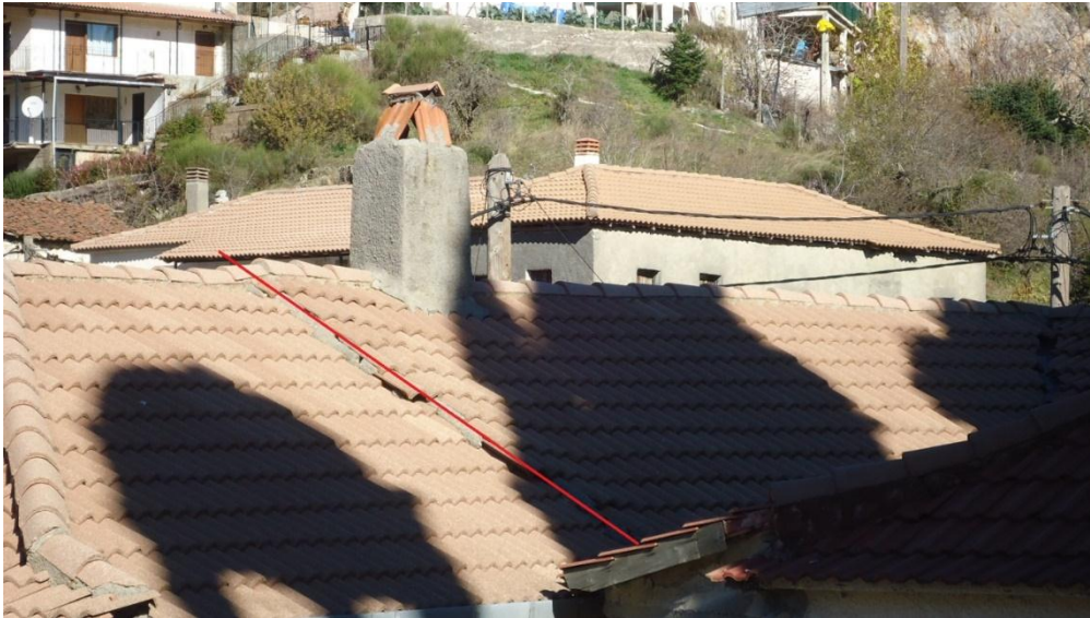
Εικόνα 45 : Εξωτερικά η σκεπή με την καμινάδα του παλιού τζακιού του σπιτιού. Η δεξιά πλευρά είναι παλιά. Λεπτομέρειες : Η κόκκινη γραμμή διαχωρίζει την παλιά κατοικία από την μετέπειτα.
