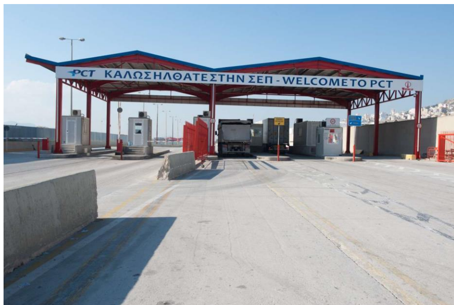
εικ.36: Πύλες εισόδου και εξόδου στο προβλήτα II. Η κατασκευή αποτελεί μέρος της αναβάθμισης του προβλήτα II.
