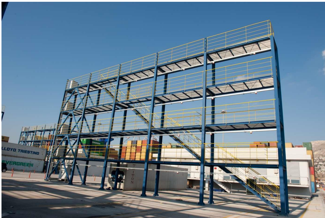
εικ.35: Μεταλλικές κατασκευές επιθεώρησης ψυγείων στο προβλήτα II. Η κατασκευή αποτελεί μέρος της αναβάθμισης του προβλήτα II.
