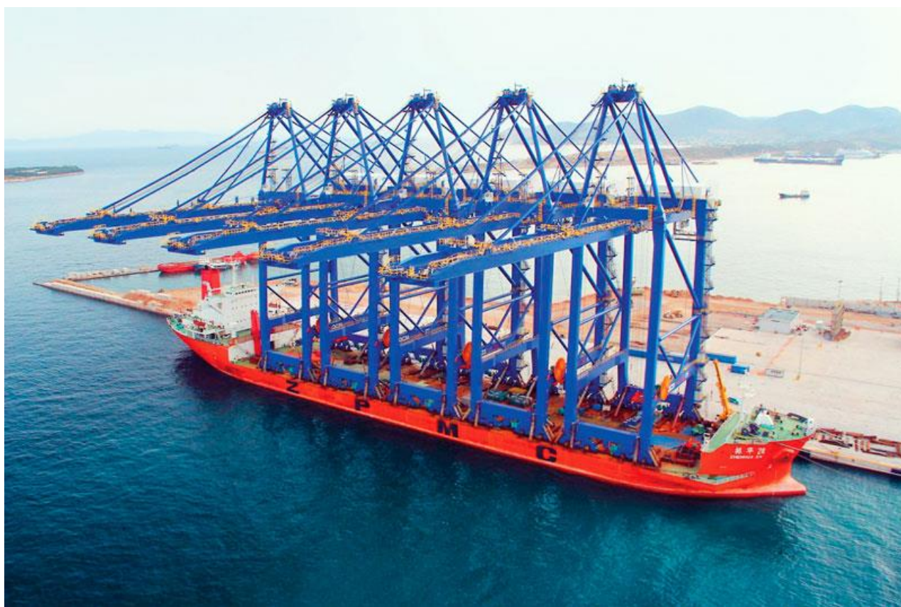
εικ.41: Η μεταφορά των 5 νέων γερανογεφυρών super-super post panama στο ανατολικό τμήμα του προβλήτα III.
