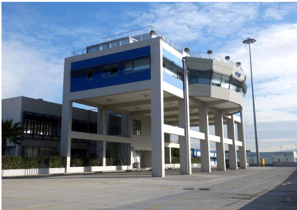
εικ.33: το νέο κτίριο διοίκησης στο προβήτα II. Το κτίριο αποτελεί μέρος της αναβάθμισης του προβλήτα II.
