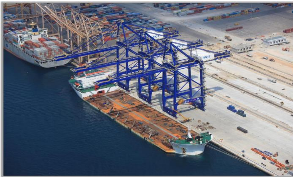
εικ.30: Τοποθέτηση των νέων γερανογεφυρών super post rana στο δυτικό τμήμα του Προβλήτα II.
