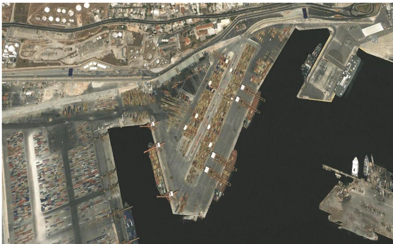
εικ.22: Προβλήτας Ι μετά την επέκταση .Παρούσα κατάσταση
