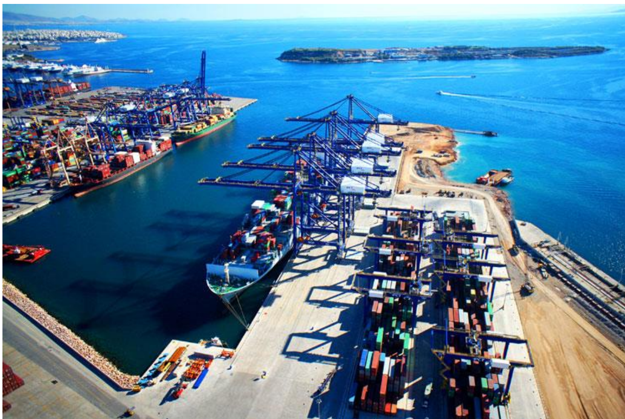
εικ.42: η κατασκευή του ανατολικού τμήματος του Προβλήτα III.
