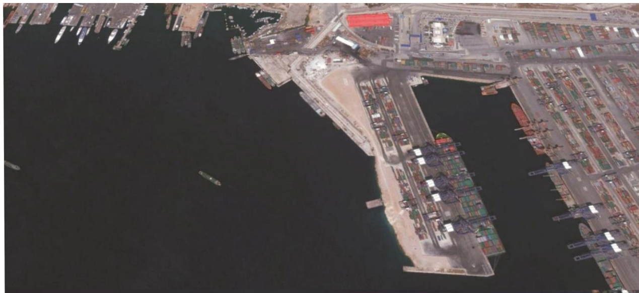
εικ.45: Ολοκλήρωση του ανατολικού και νότιου τμήματος
