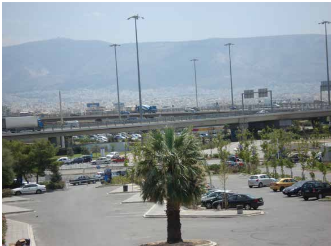
Εικόνα 69: Η υπερυψωμένη γέφυρα επί της λεωφόρου Ποσειδώνος
