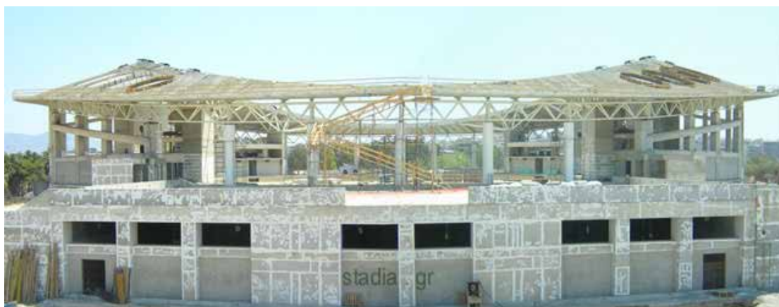
Εικόνα 7 : Το κλειστό γυμναστήριο του Φαλήρου κατά την διάρκεια κατασκευής
