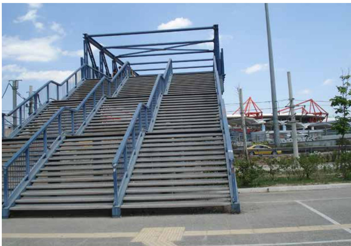
Εικόνα 70: Πεζογέφυρα που βρίσκεται στο ΣΤΕΦ
