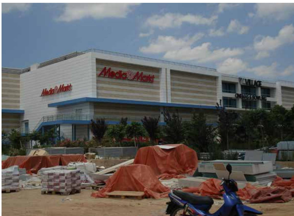
Εικόνα 73: Κατάστημα Media Markt στην περιοχή του Δέλτα Φαλήρου
