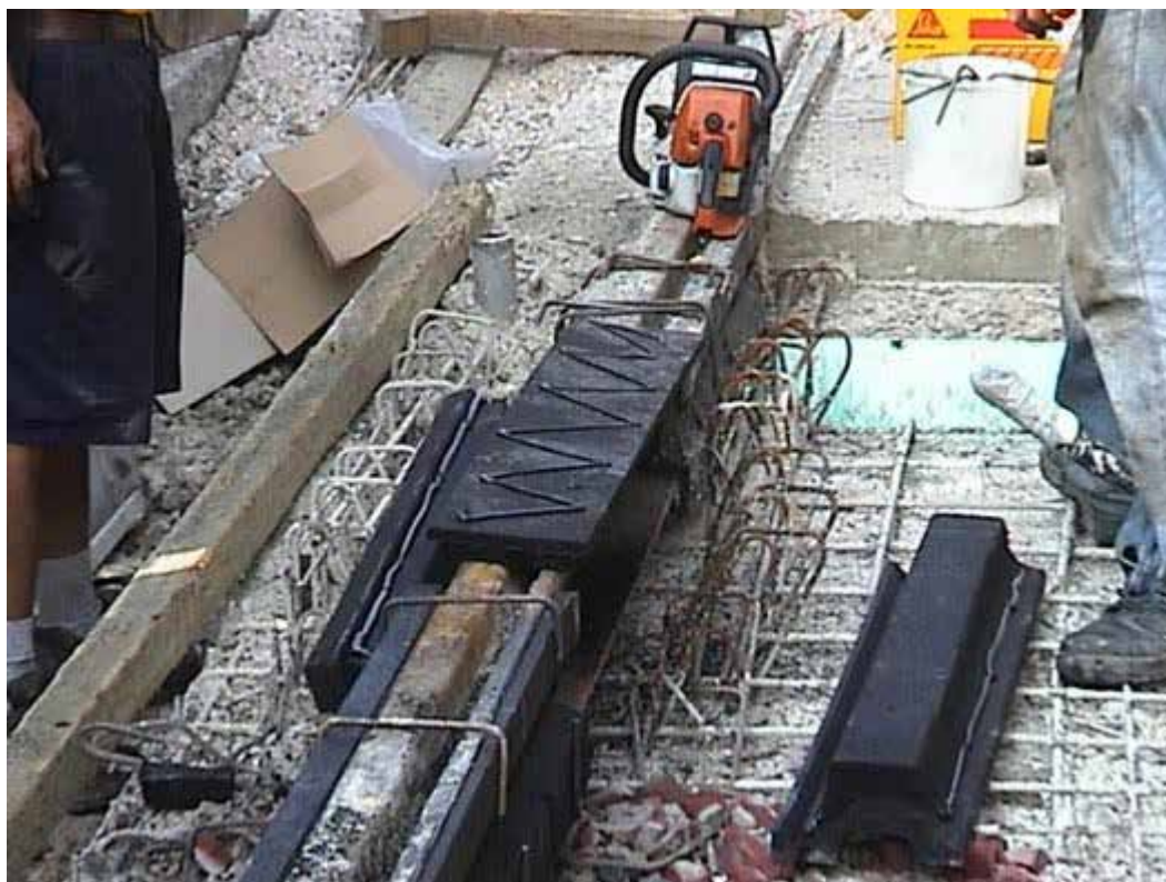
Εικόνα 24: Έργα κατά την διάρκεια κατασκευής των γραμμών του τραμ
