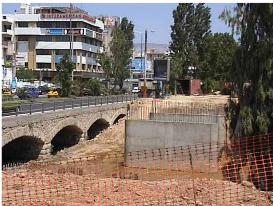
Εικόνα 23: Έργα κατά την διάρκεια κατασκευής των γραμμών του τραμ
