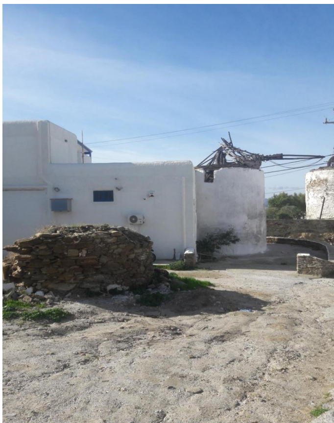
Εικόνα 6 : Υφιστάμενη κατάσταση ανεμόμυλων 4 & 5.
