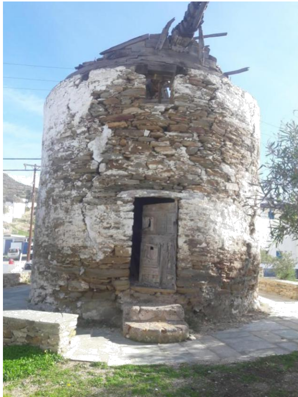
Εικόνα 4 : Υφιστάμενη κατάσταση μύλου 3.
