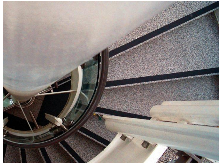
Εικόνα 3.1.3: Μέτρα ασφάλειας σκάλας (μέγεθος πατήματος σκάλας, αντιολισθητικές επιφάνειες και ταινίες)
