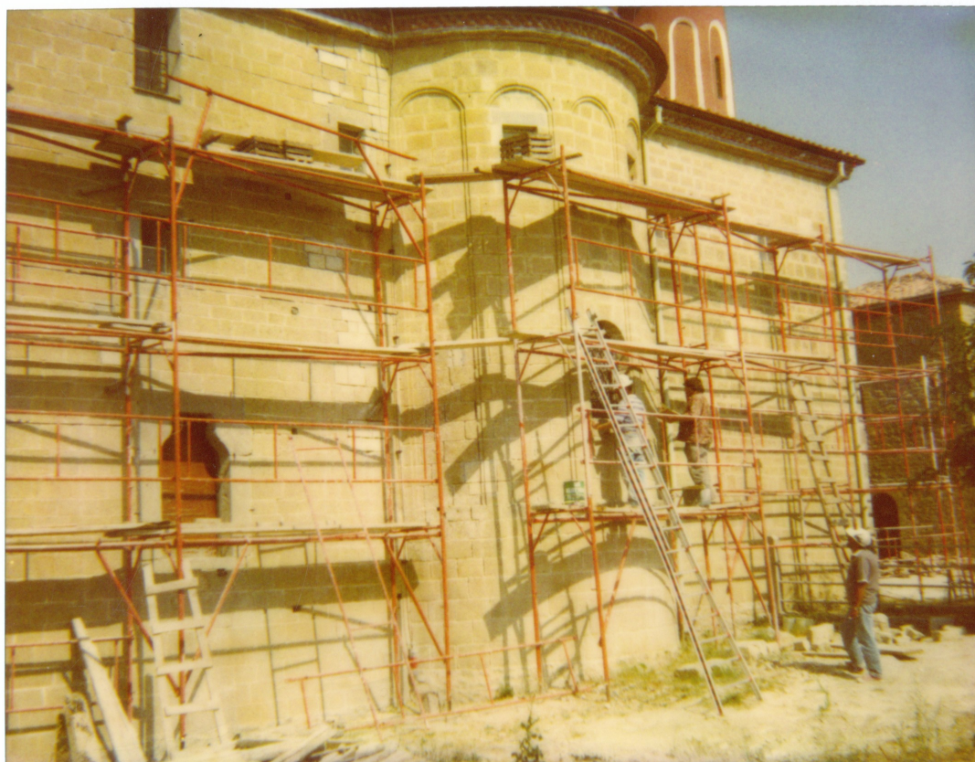
Η νότια πλευρά ολοκληρωμένη και έτοιμη για την αφαίρεση των σκαλωσιών. Πηγή: Τζήμας Σωτήριος – Ιερά Μονή Αγίου Στεφάνου.
