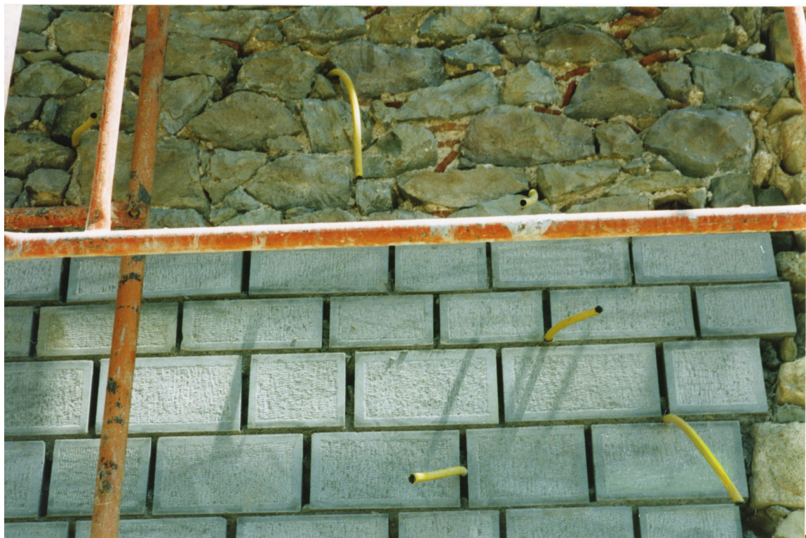
Τα σωληνάκια από PVC έχουν τοποθετηθεί και όλα είναι έτοιμα για να αρχίσει η αρμολόγηση. Το κονίαμα προωθείται με ειδικό μηχάνημα μέσω αυτών των εύκαμπτων σωληνών στο εσωτερικό της τοιχοποιίας με σχετικά χαμηλή πίεση γεμίζοντας όλα τα κενά. Πηγή: Τζήμας Σωτήριος – Ιερά Μονή Αγίου Στεφάνου.
