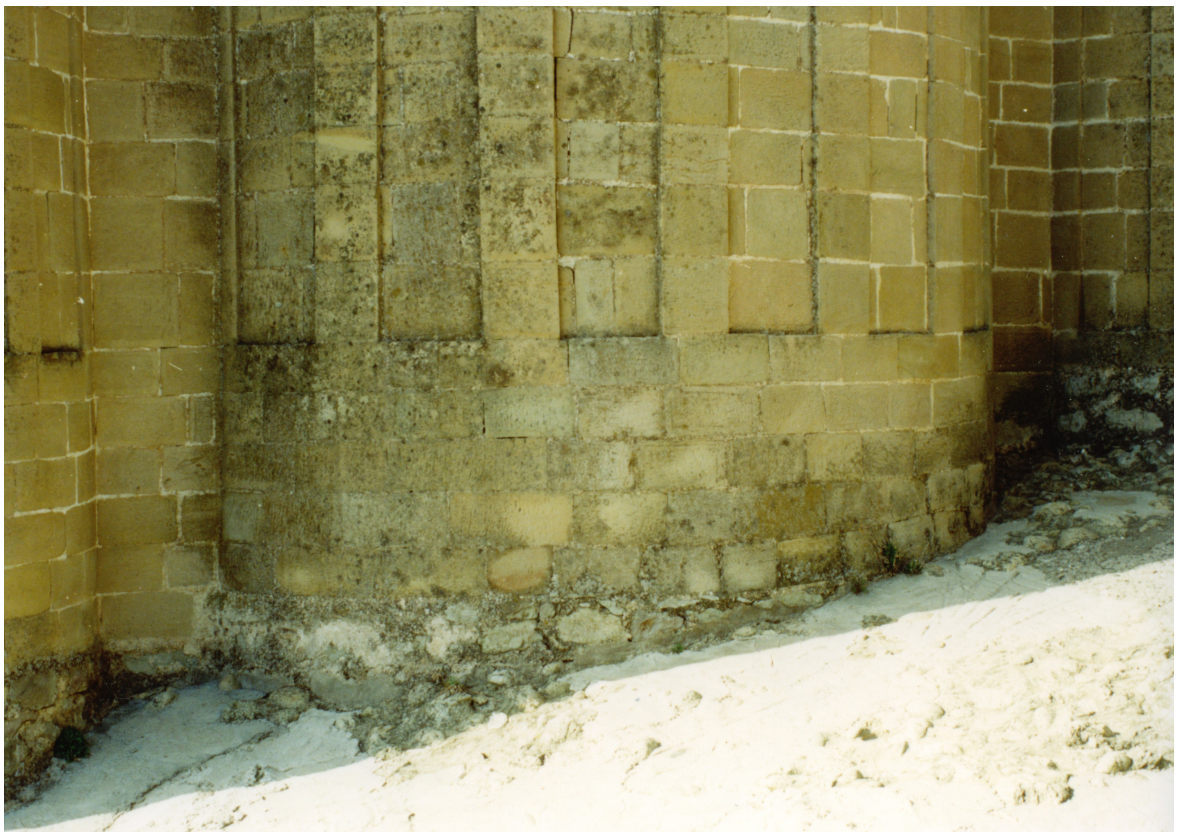
Σημαντική φθορά παρατηρείται στη βάση της τοιχοποιίας.
