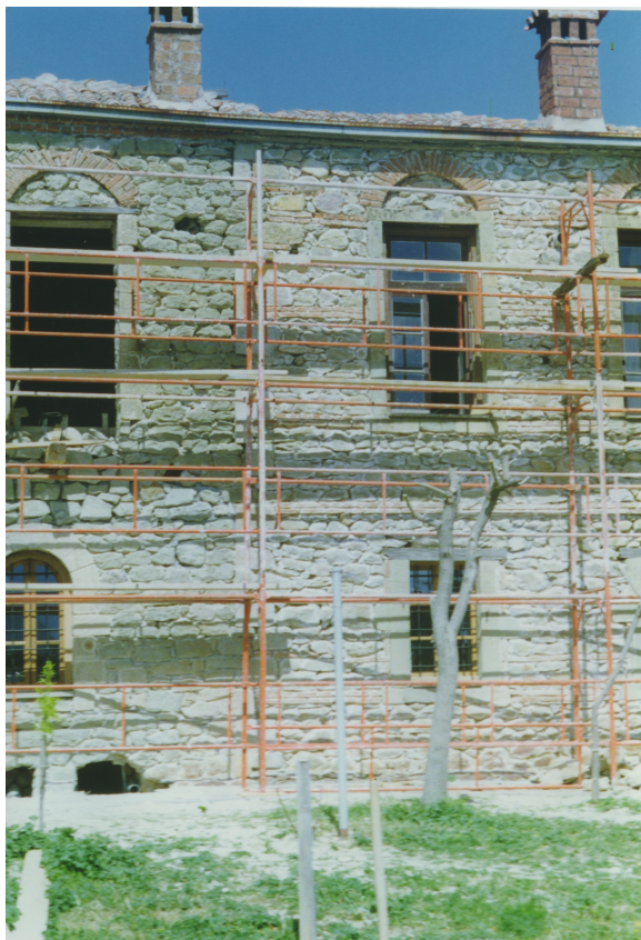
Η κατασκευή νέων μπαλκονιών.
