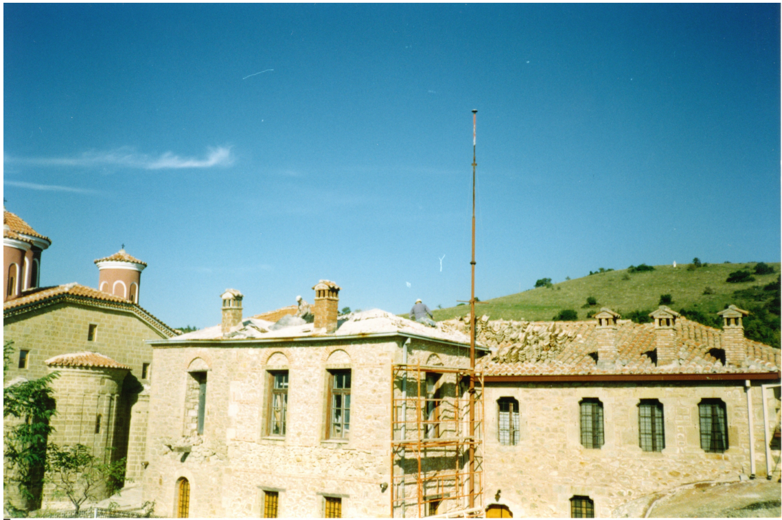
Η στέγη αντικαθίσταται επίσης.
