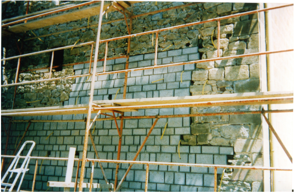
Η διαδικασία της αντικατάστασης των λίθων ολοκληρώθηκε. Πηγή: Τζήμας Σωτήριος – Ιερά Μονή Αγίου Στεφάνου.
