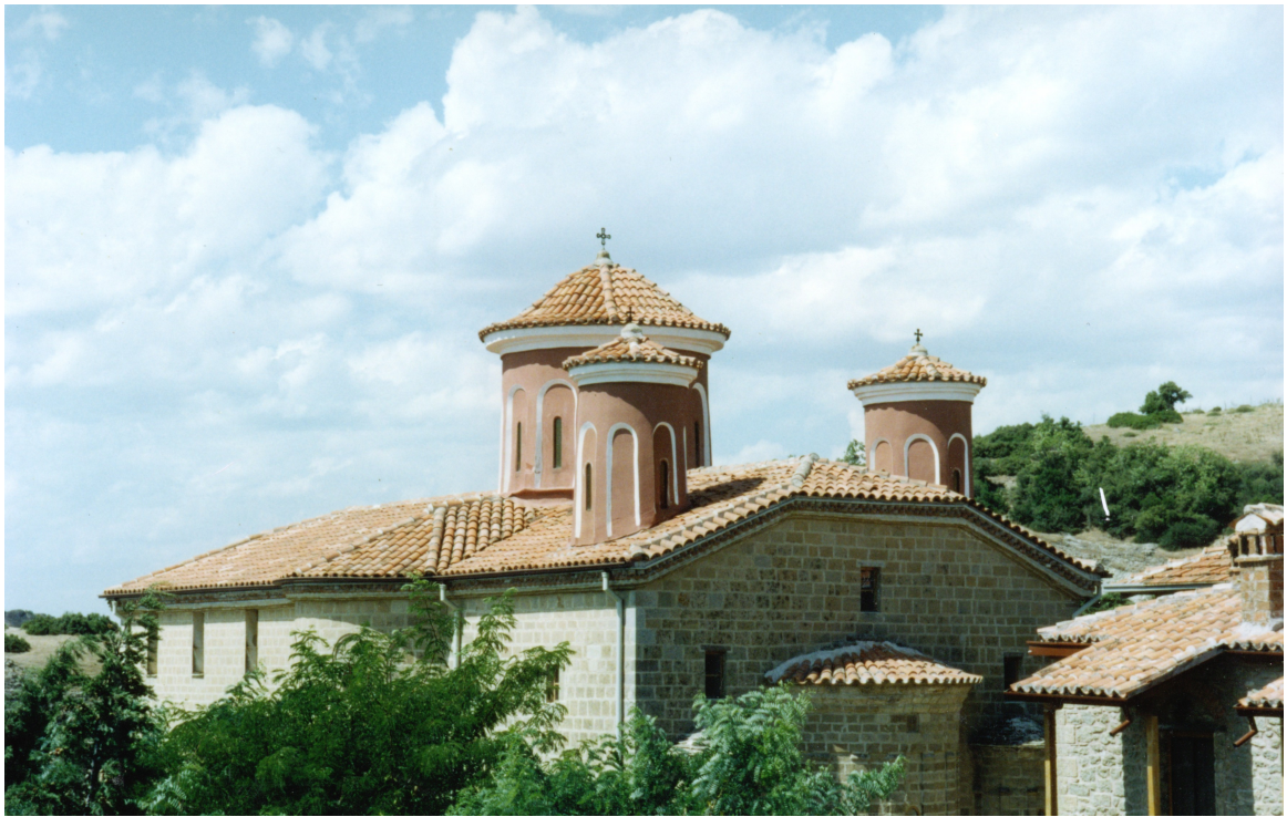
Η στέγη πριν την έναρξη των εργασιών.
