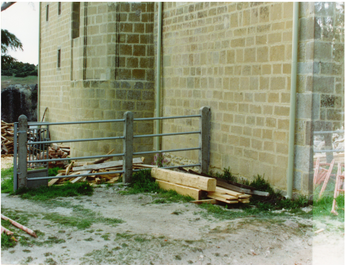
Και η βάση μετά την επισκευή.
