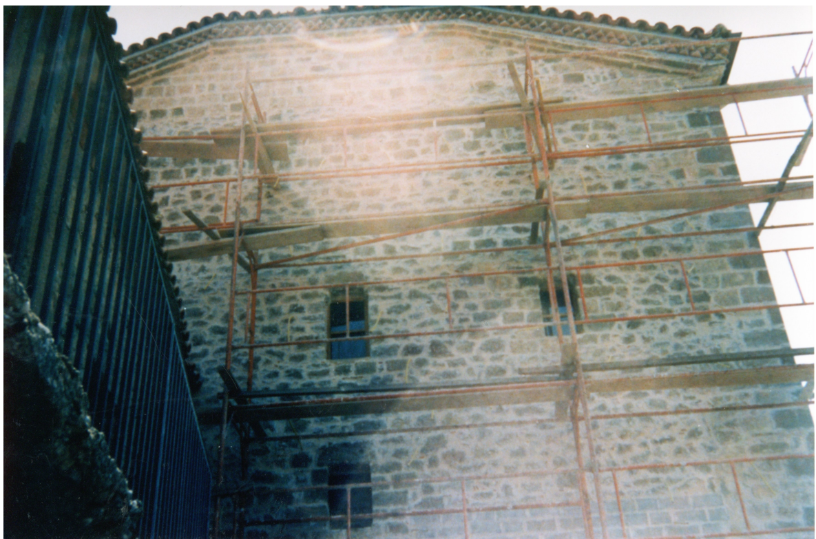
Η δυτική πλευρά μετά το πέρας των εργασιών.
