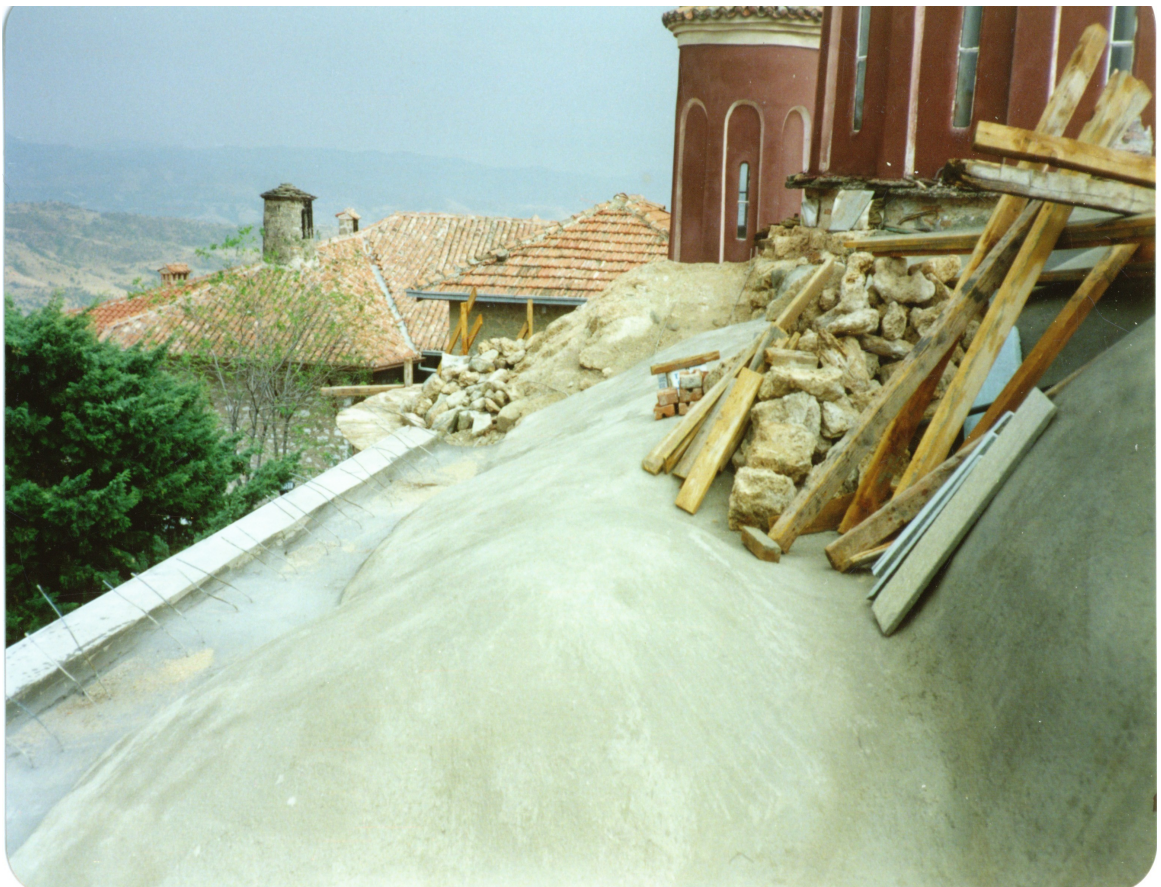
Η ενίσχυση της οροφής ολοκληρωμένη.
