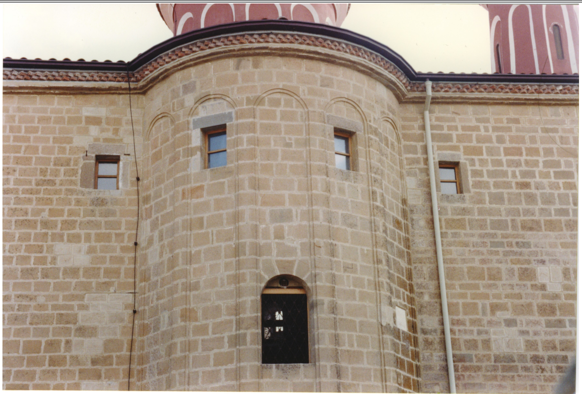
Το κεντρικό τμήμα μετά την επισκευή.
