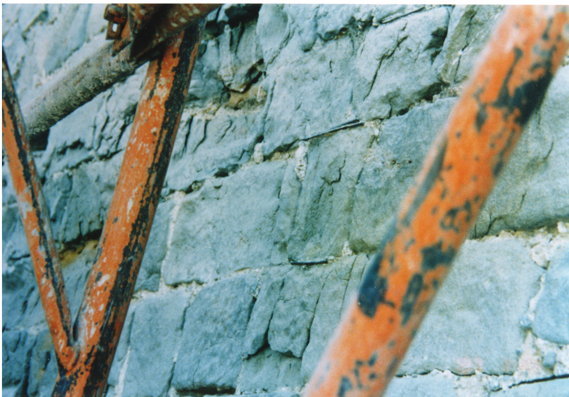
Αφού πρώτα πραγματοποιήθηκε η μελέτη και αποφασίστηκε ο τρόπος επέμβασης εντοπίζουμε τα σημεία που θα επέμβουμε και εντοπίζουμε ποιοι λίθοι θα αντικατασταθούν.
