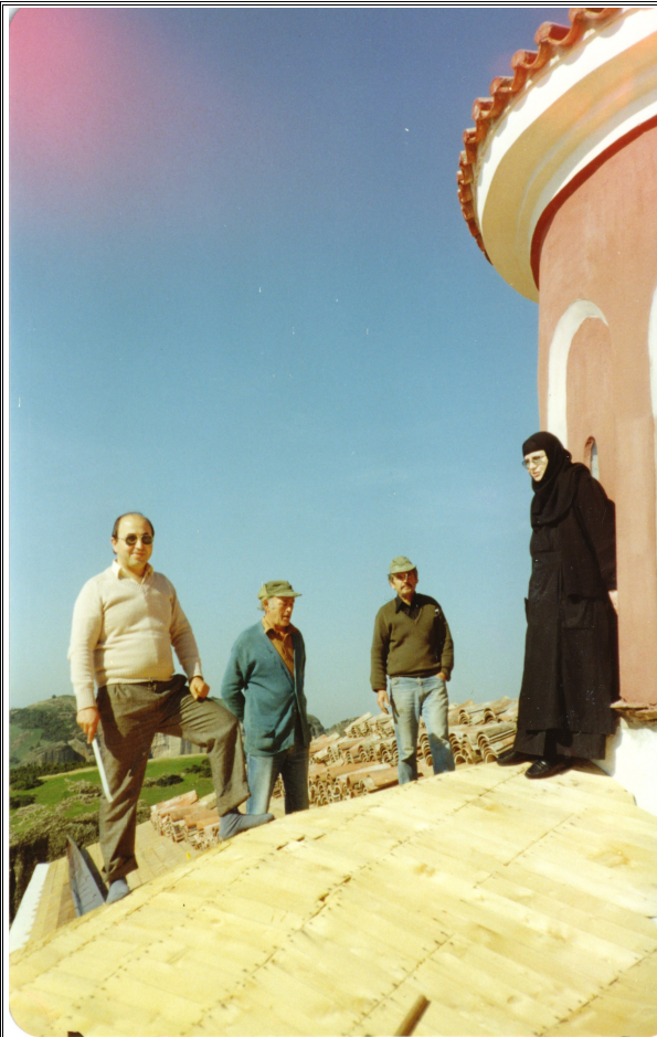
Τοποθέτηση του πετσώματος της στέγης.
